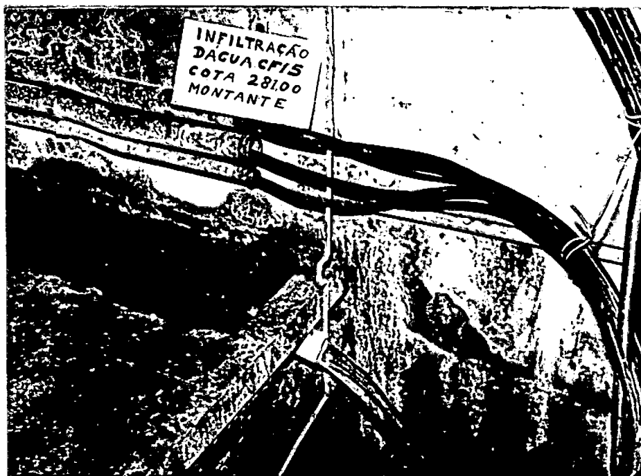
Medida de vazão feita na Casa de Força-15.
