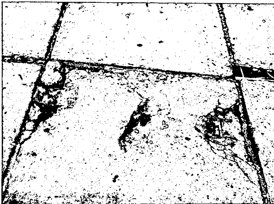
Placas danificadas pelas agulhas durante a movimentação das placas.
