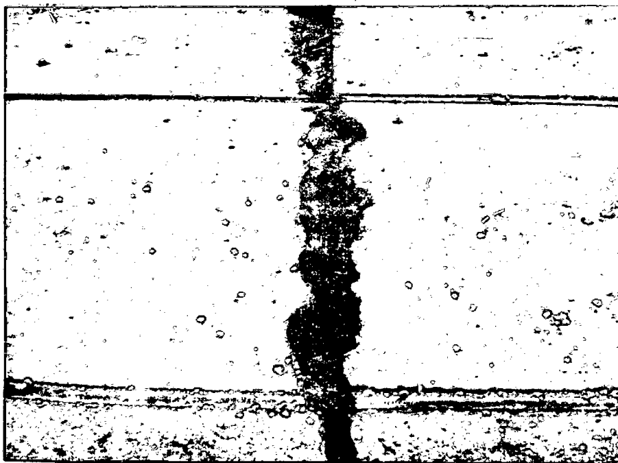
Expulsão do enchimento da junta pela movimentação das placas.
