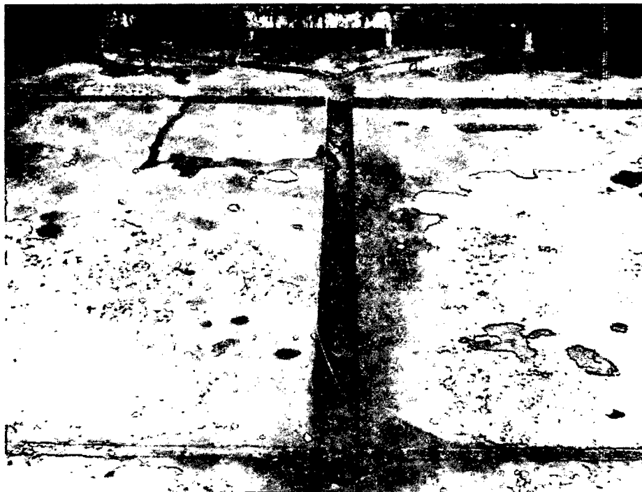
Vista das juntas de vedação, sem sanar totalmente o problema de infiltração.
