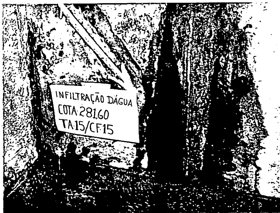
Infiltrações d'água na cota 281,60.
