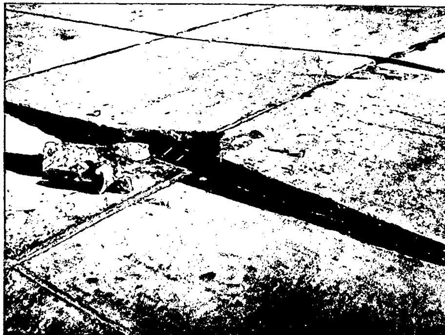
Deslocamento vertical causado pela movimentação.
