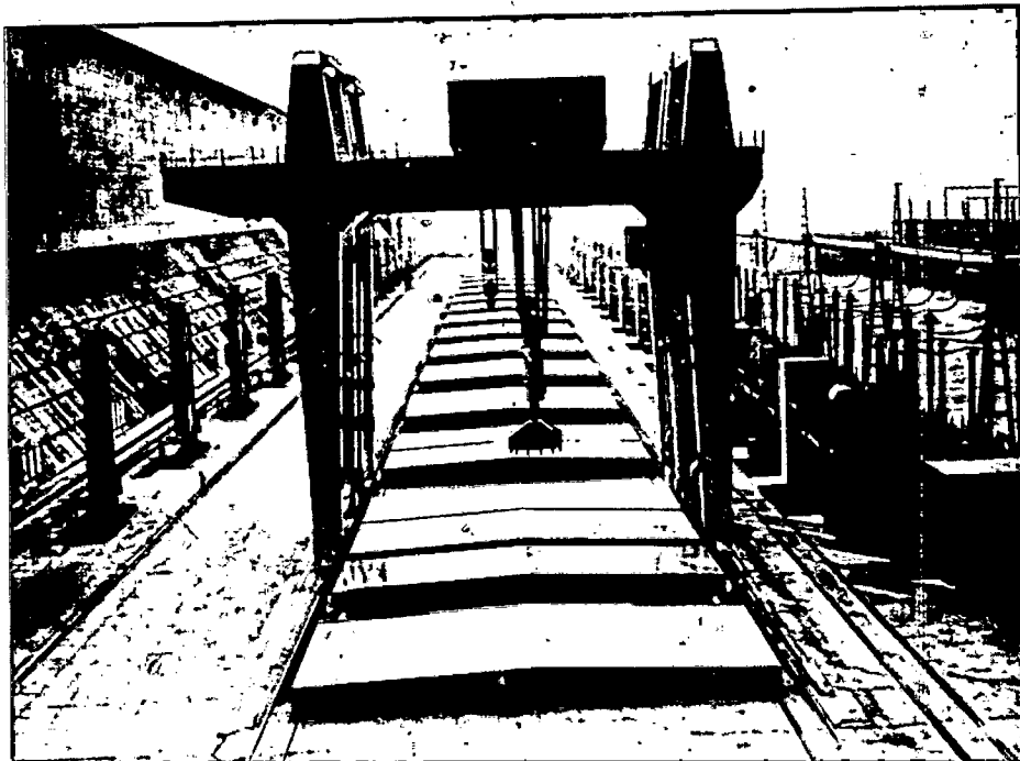
Vista geral dos trilhos dos Pôrticos de 280t.
