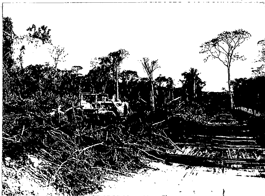
Desmatamento para implantação da estrada.
