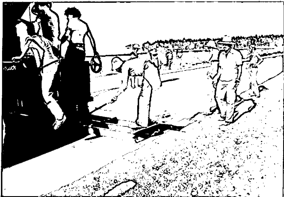
Foto 11 - Detalhe de aplicação de camada de Lama Asfáltica.
