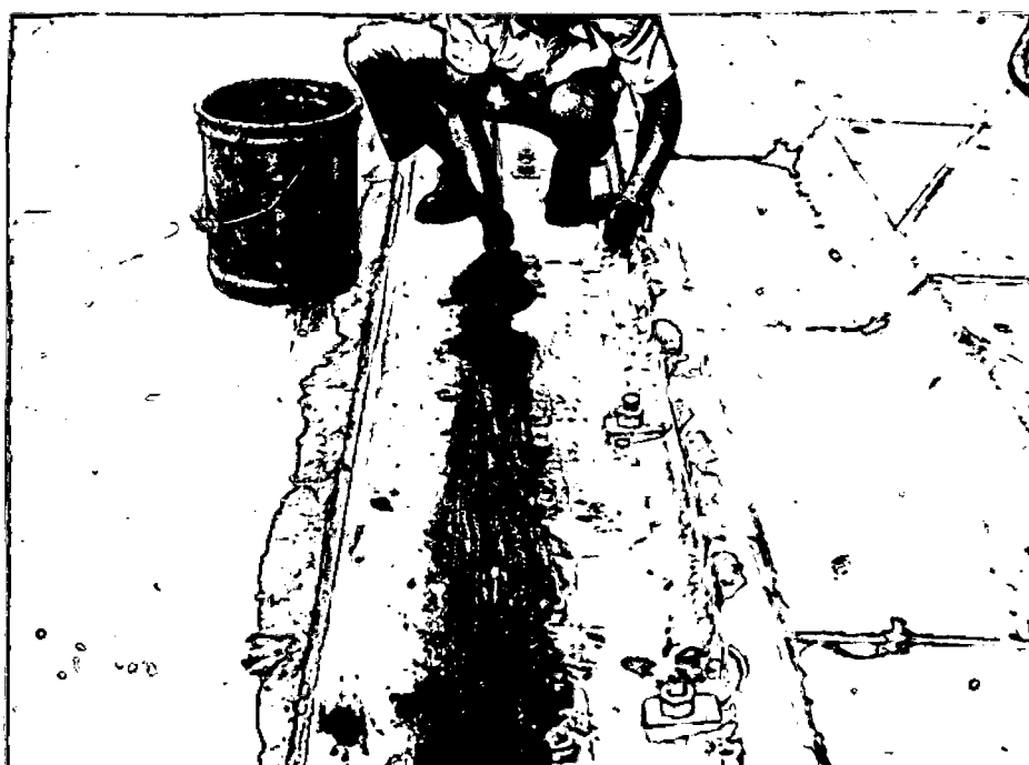
Aplicação do Mastique Isoplast (não elastômero).
