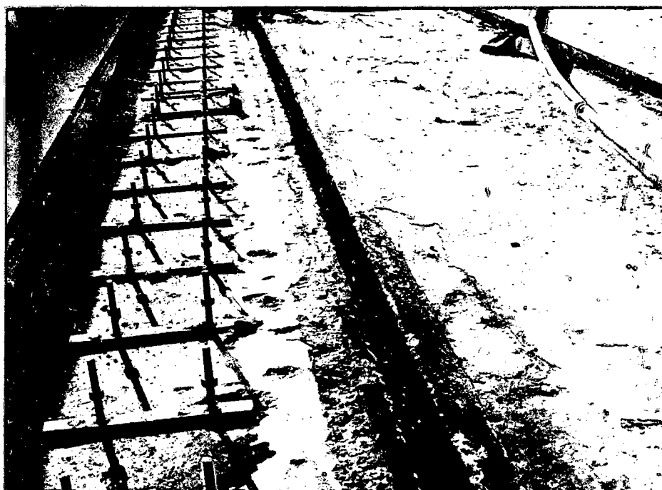
Junta de concretagem preparada com jato de areia.
