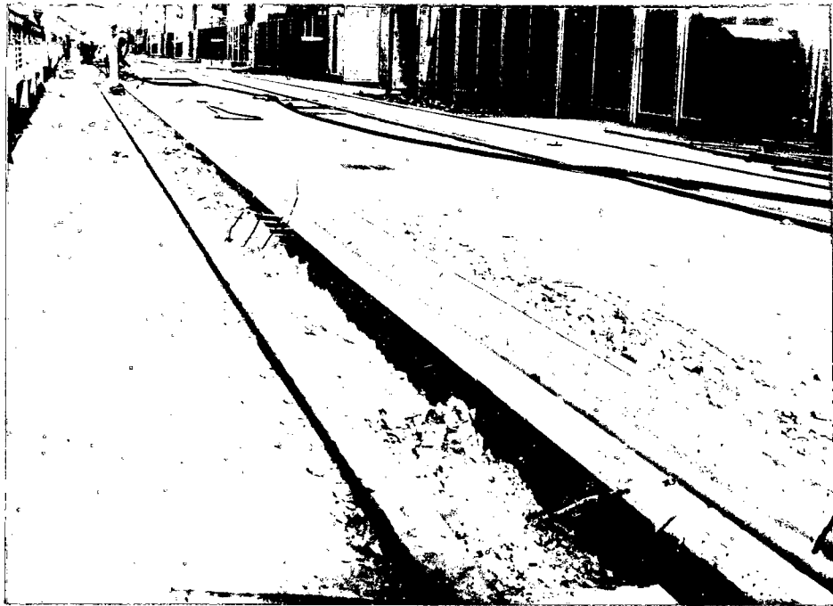
Rompimento do concreto junto à canaleta de cabo do Pórtico de 280t.
