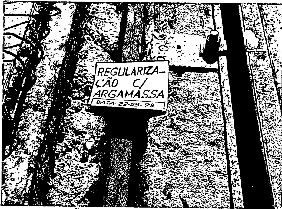
Regularização da junta de dilatação com argamassa.
