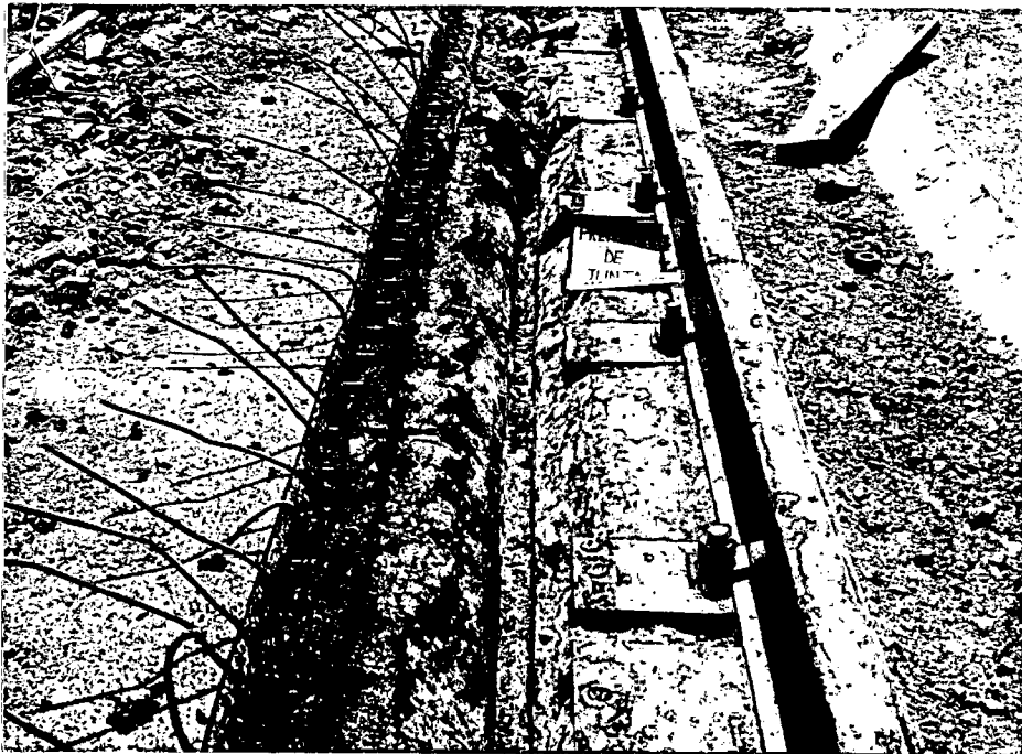
Rompimento das placas de concreto junto ao trilho da TA16 a TA20.
