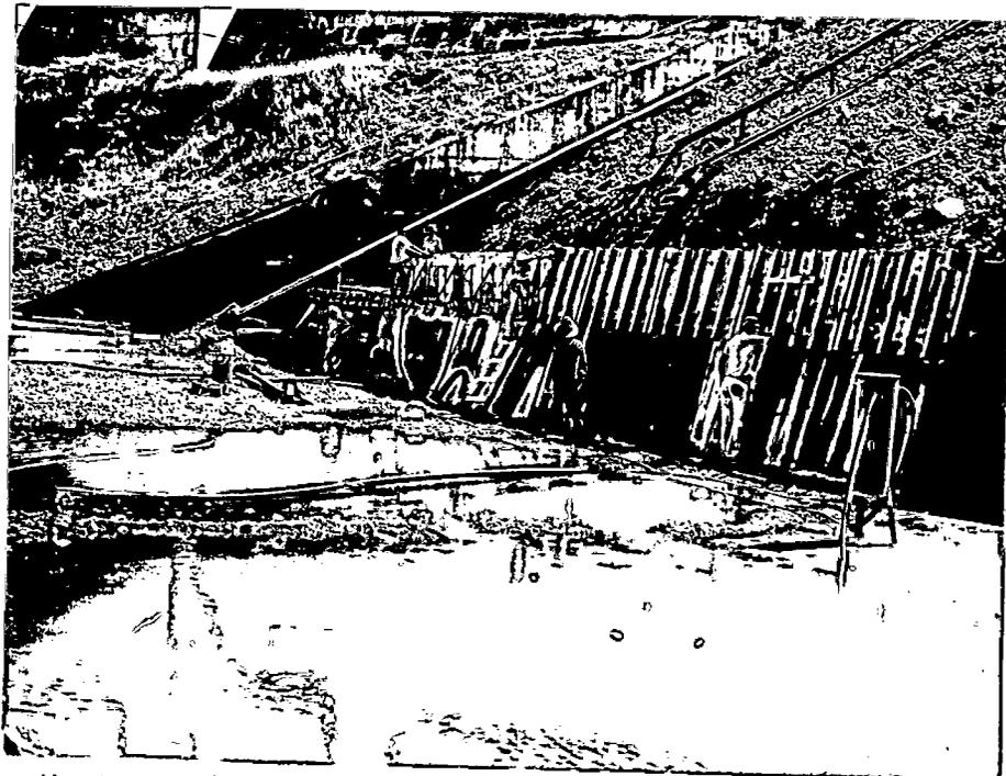
Montagem de formas para a 2ª etapa de concretagem do muro, no seu trecho final junto ao Canal de Fuga da Eclusa.
