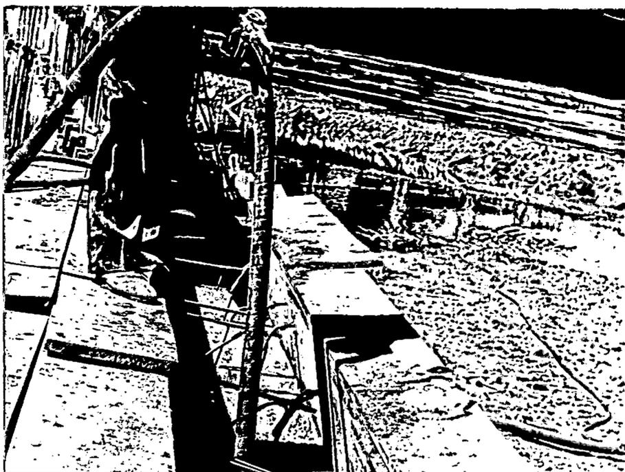
Adensamento do concreto por meio de vibrador de imersão.
