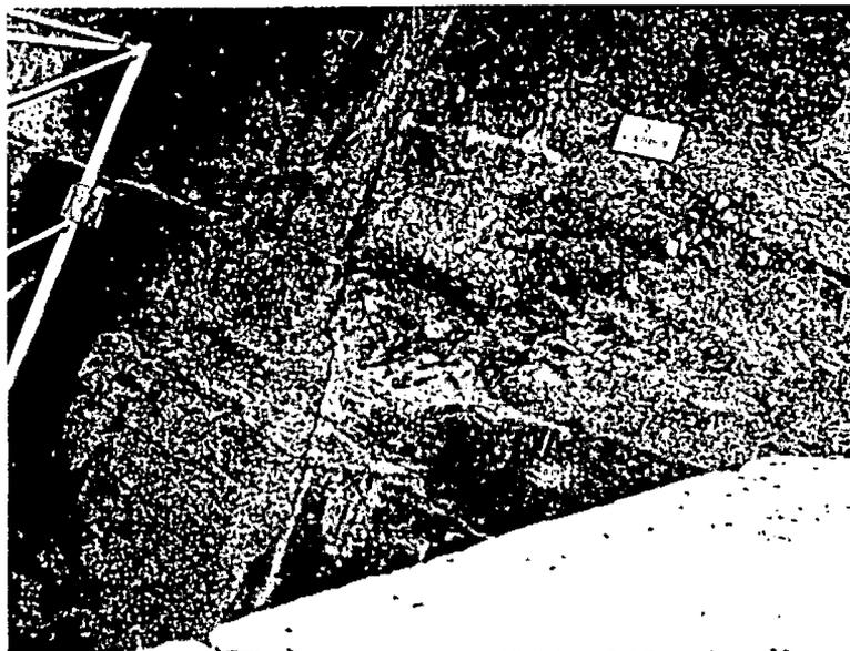
Aspecto de uma superfície a ser reparada, com cavitação de pequena profundidade.
