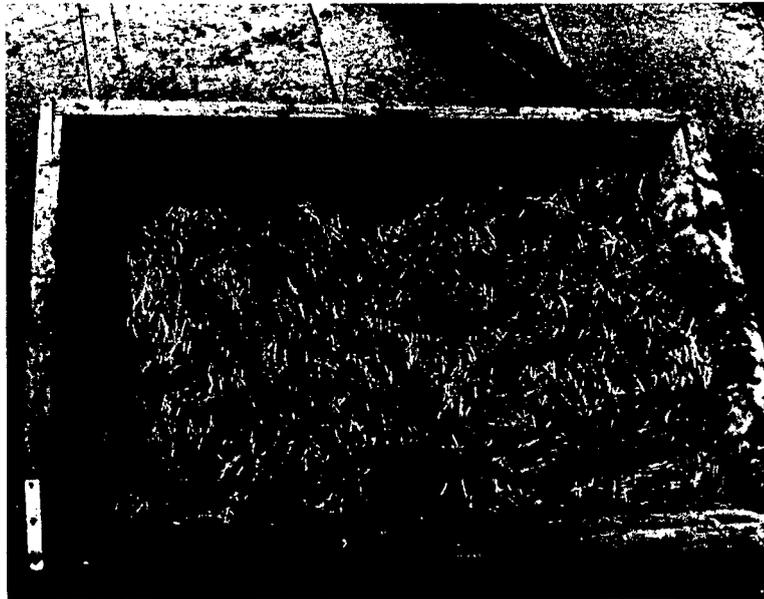
Homogeneização da mistura das fibras com areia, com auxílio de enxadas.
