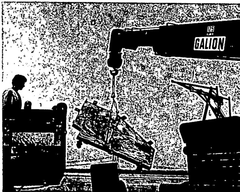
Operação de passagem da chapa de aço do caminhão para o flutuador, na margem do rio.
