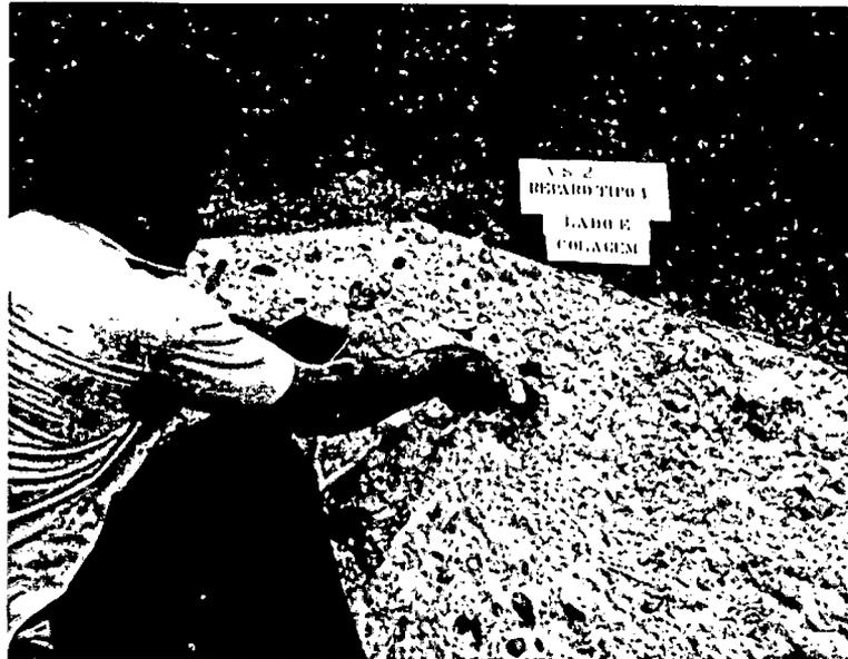
Aplicação da resina epóxica sobre a superfície do concreto para colagem da argamassa epóxica.
