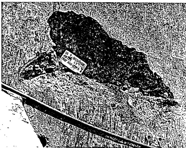
Erosão profunda devido à cavitação.
