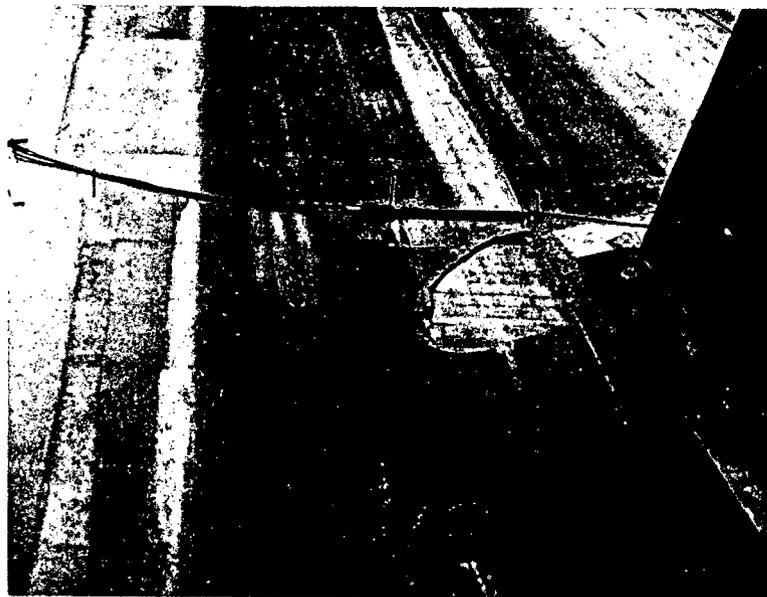
Vista da cavidade preenchida com concreto, vendo-se o rebaixo de 5cm para permitir a aplicação da argamassa epóxica.
