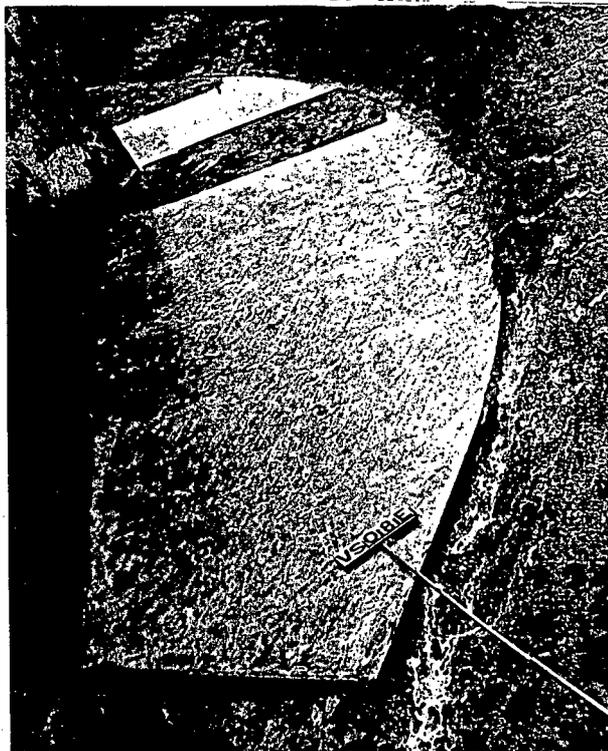
Soldura parcial do revestimento com chapa inóx, permanecendo porém, a chapa de aço comum, no VS 8, lado esquerdo do dente dissipador.
