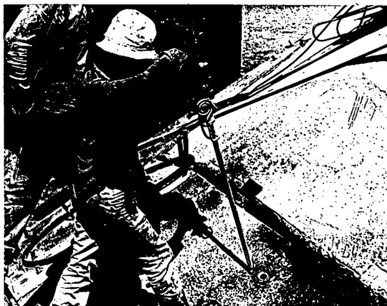
Haste de perfuração do concreto através dos furos da chapa, com 80cm de profundidade, para colocação dos chumbadores de ancoragem.
