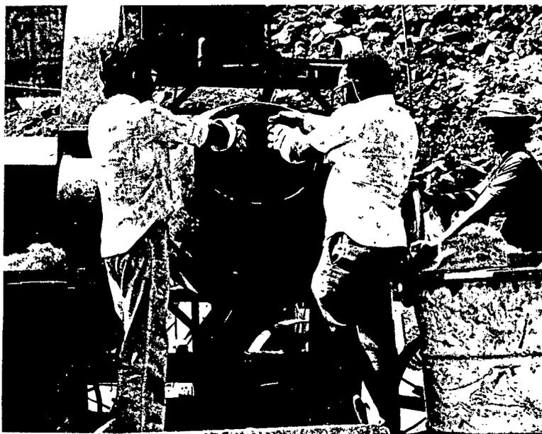
Usinagem do concreto fibroso, vendo-se o depósito de fibras ao lado.
