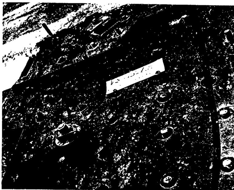
Transpasse dos chumbadores na chapa, faltando apenas a solda para fixação.
