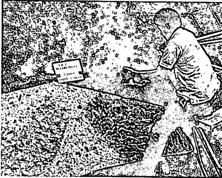
Delimitação da área de reparo com utilização de equipamentos pneumáticos e disco de nailon.
