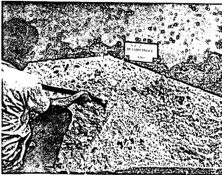
Limpeza da superfície com o emprego de ar comprimido.
