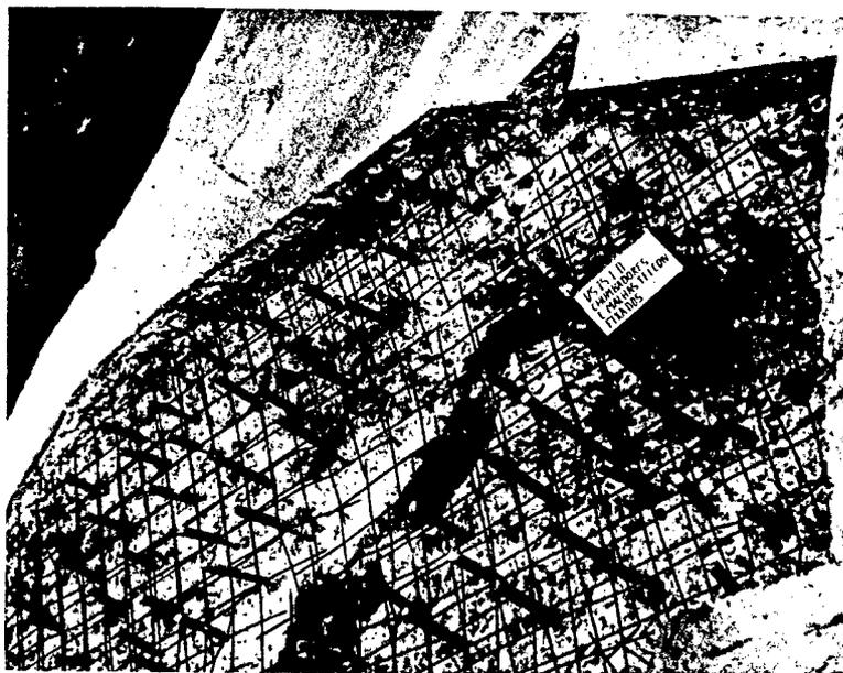
Chumbadores e armadura de pele preparados para a aplicação de resina epóxica para colagem do concreto secundário com o concreto primário.
