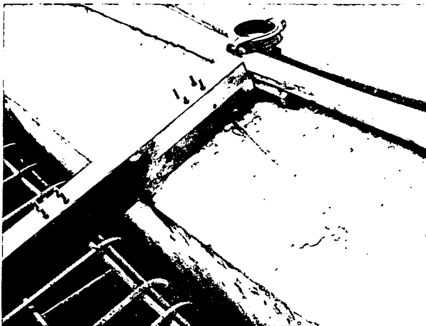
FORMAS TEMPORARIAMENTE FIXAS DO BLOCO "B" - VISTA DO APOIO DA LONGARINA PRINCIPAL SOBRE O CONCRETO EXISTENTE DO BLOCO "A" NA SUA FASE ORIGINAL DE CONSTRUÇÃO.
