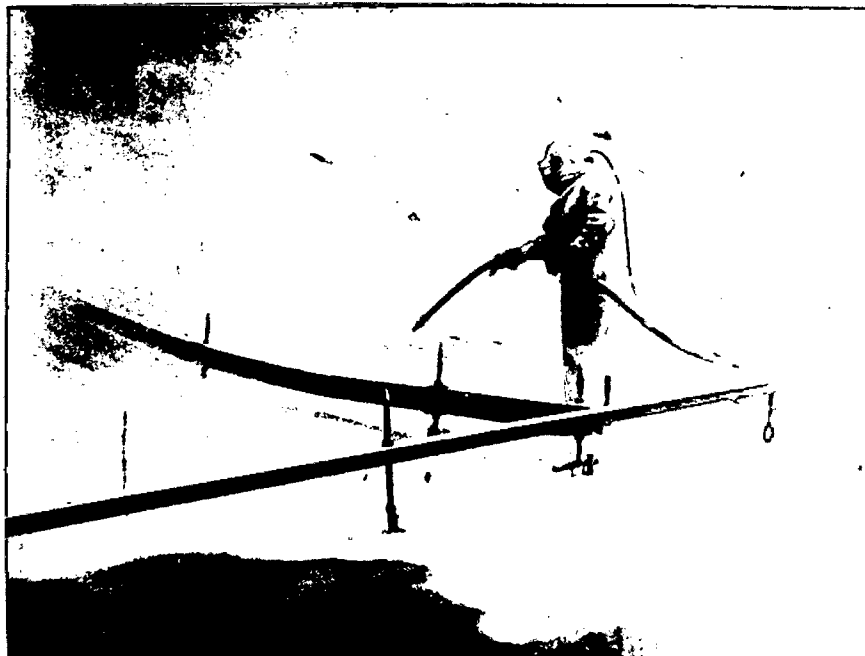
VISTA DA REGIÃO DO ENCAIXE DA CONCORDÂNCIA SEN DO JATEADA COM AREIA.
