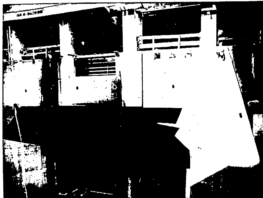
VISTA MOSTRANDO NO CF-20, AS PAREDES PROVISÓRIAS DE JUSANTE ROMPIDAS.
