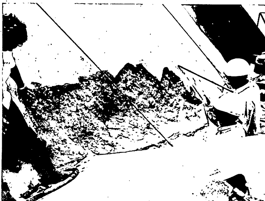
VISTA MOSTRANDO O MATERIAL APLICADO ESCORRENDO.
