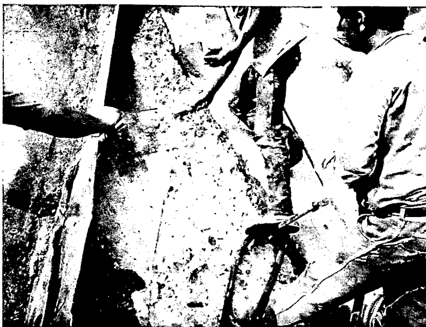
VISTA MOSTRANDO APLICAÇÃO DA COLA COM PINCEL.
