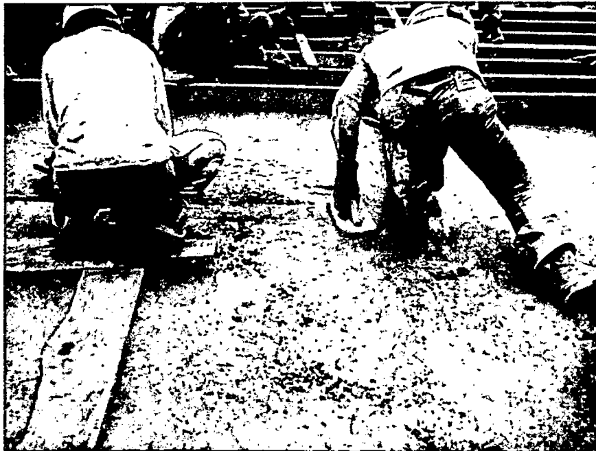
VISTA MOSTRANDO O ACABAMENTO COM DESEMPENADEIRA
