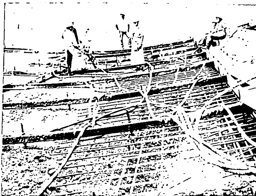
FORMAS TEMPORARIAMENTE FIXAS DO BLOCO "B" - LANÇAMENTO NA REGIÃO DO PC DA CURVA, NA SUA FASE ORIGINAL DE CONSTRUÇÃO.
