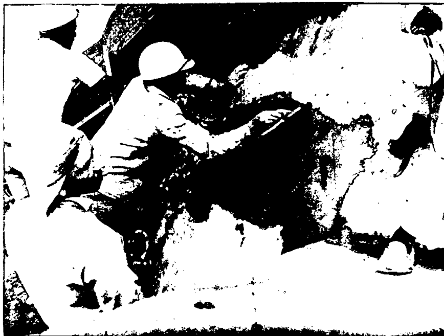
VISTA MOSTRANDO APLICAÇÃO DA ARGAMASSA E O INÍCIO DO ACABAMENTO COM DESEMPENADEIRA .
