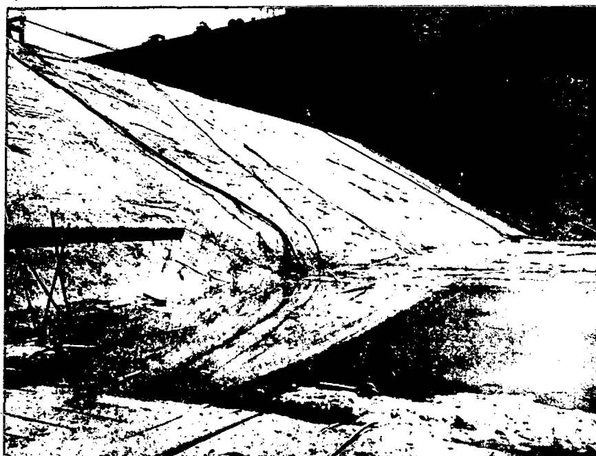
VISTA MOSTRANDO OS DESGASTES NOS BLOCOS DA LINHA "F" E LINHA "E" PRÓXIMOS AO MURO CENTRAL
