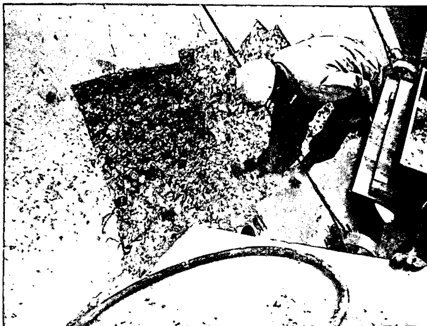
VISTA MOSTRANDO APLICAÇÃO DA COLA COM PINCEL
