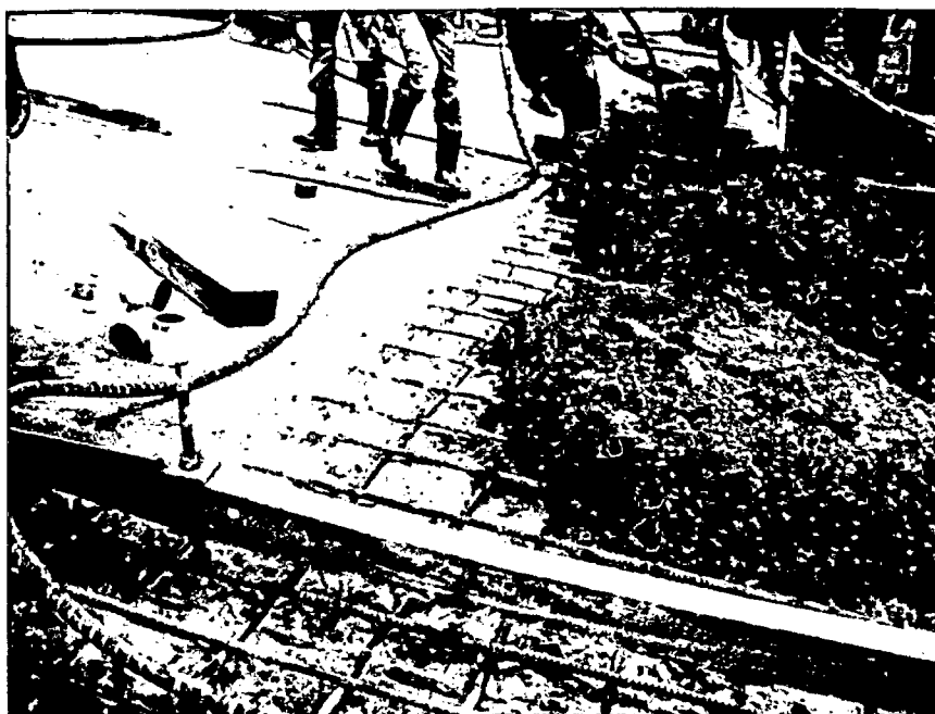
VISTA MOSTRANDO A REGIÃO DO ENCAIXE COM APLICAÇÃO DA COLA (COLMA-FIX-32).
