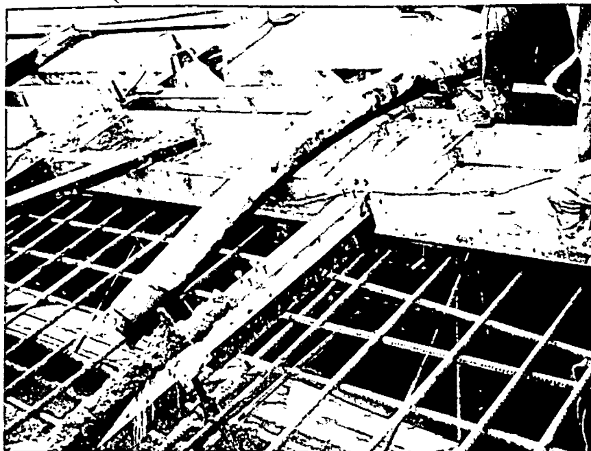
FORMAS TEMPORARIAMENTE FIXAS BLOCO "B" - BOMBA INJETORA DE CONCRETO (WHITEMAN) UTILIZA DA EM CERTOS BLOCOS PARA LANÇAMENTO NA SUA FA SE ORIGINAL DE CONSTRUÇÃO.
