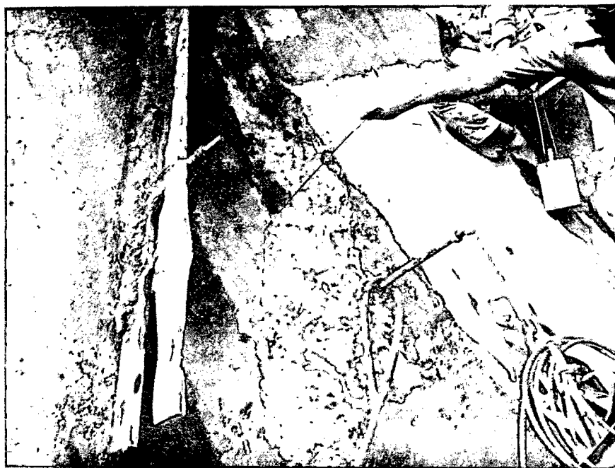
VISTA DO REPARO ENTRE AS JUNTAS DOS BLOCOS 5 E 6 MOSTRANDO A ÁREA COMPLETAMENTE ROMPIDA E CORTADA COM DISCO.
