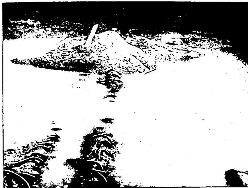
VISTA MOSTRANDO O REPARO FEITO COM O LANÇAMEN- TO SUBMERSO, APÓS O ESWAZIAMENTO DA BACIA.
