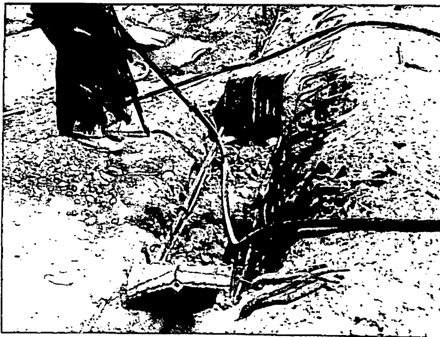
VISTA MOSTRANDO O ROMPIMENTO NA REGIÃO DO MATA-JUNTA, PARA QUE ESTE PUDESSE SER RECUPERADO.
