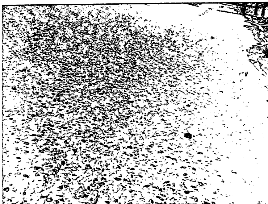
VISTA MOSTRANDO UMA REGIÃO DA LINHA "B" PRONTA PARA RECEBER ARGAMASSA DE "COLMA DUR".
