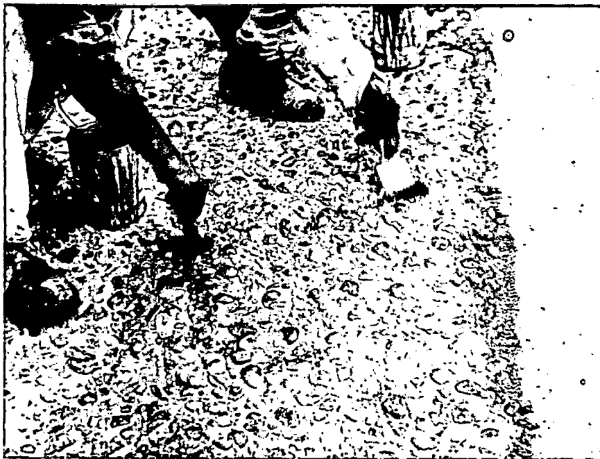
VISTA MOSTRANDO APLICAÇÃO DA COLA COM PINCEL
