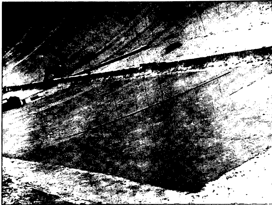
VISTA MOSTRANDO O ACABAMENTO DADO A UM BLOCO DA LINHA "B" REPARADO COM ARGAMASSA DE COLMA DUR
