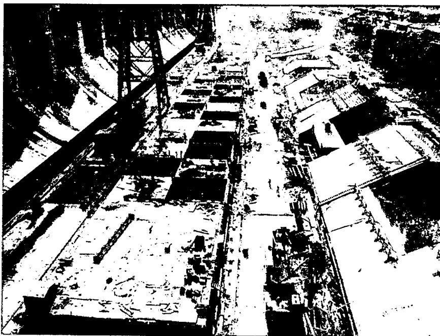
VISTA GERAL DOS VERTEDOUROS NA REGIÃO DOS BLOCOS B, C, D, E e F, BEM COMO O SISTEMA DE FORMA UTILIZADA PARA LANÇAMENTO NA SUA FASE ORIGINAL DE CONSTRUÇÃO.
