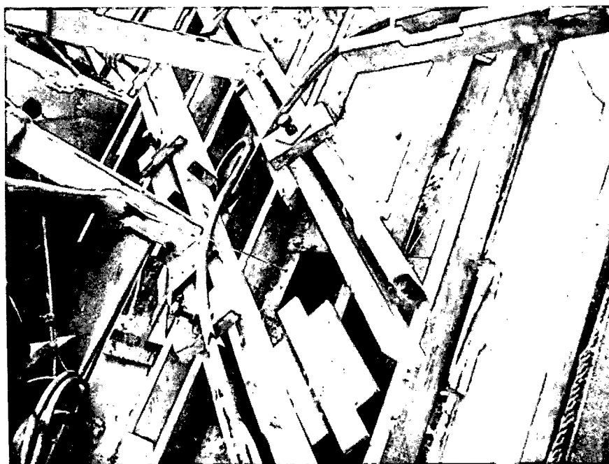
VISTA MOSTRANDO AS ABERTURAS DEIXADAS NA FORMA
