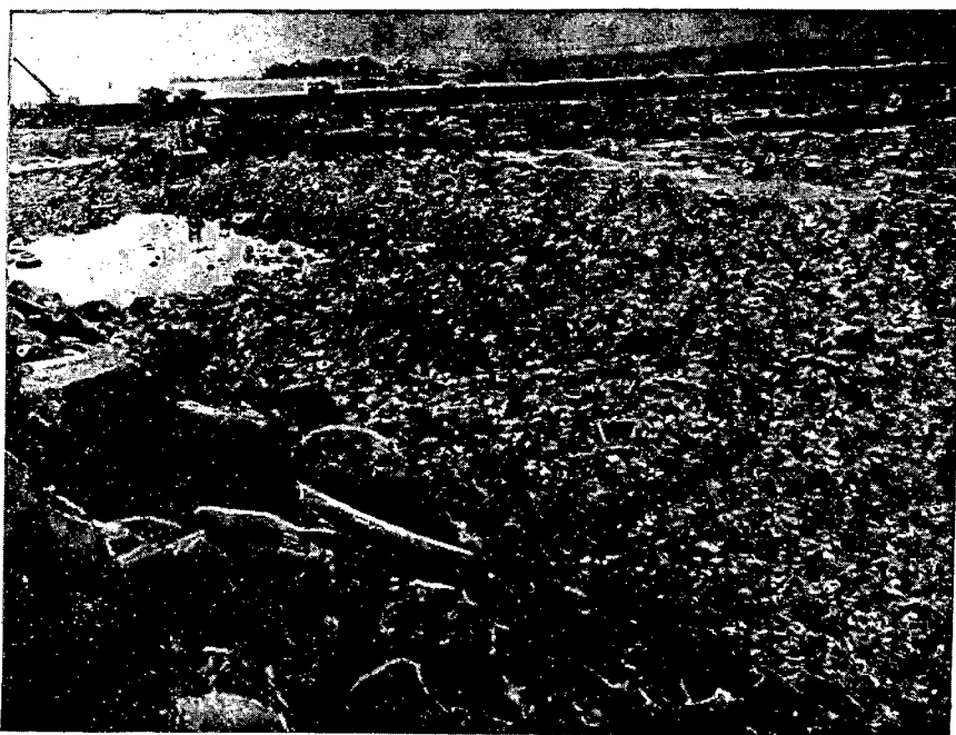
VISTA MOSTRANDO OS MATERIAIS SOLTOS A JUSANTE DO BLOCO "F" ANTES DE SE INICIAR A ESCAVAÇÃO.
