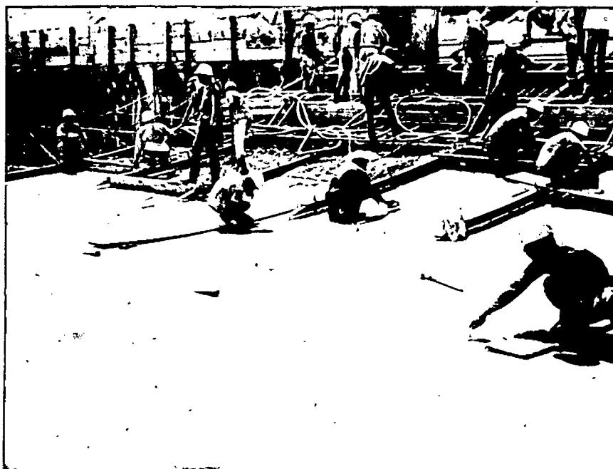
FORMAS TEMPORARIAMENTE FIXAS BLOCO "B" - ACABAMENTO FINAL DO BLOCO NA REGIÃO DA CURVA NA SUA FASE ORIGINAL DE CONSTRUÇÃO.
