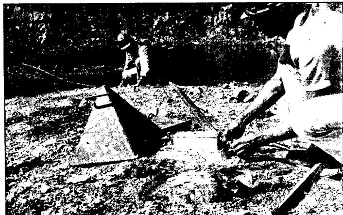
INSTALAÇÃO DE GEOPHONE PARA CAPTAÇÃO DE VIBRAÇÃO.
