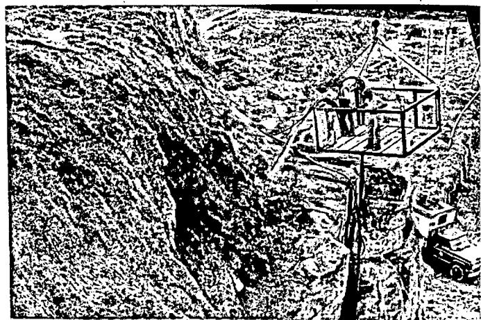
TRATAMENTO DE TALUDE COM CONCRETO PROJETADO.
