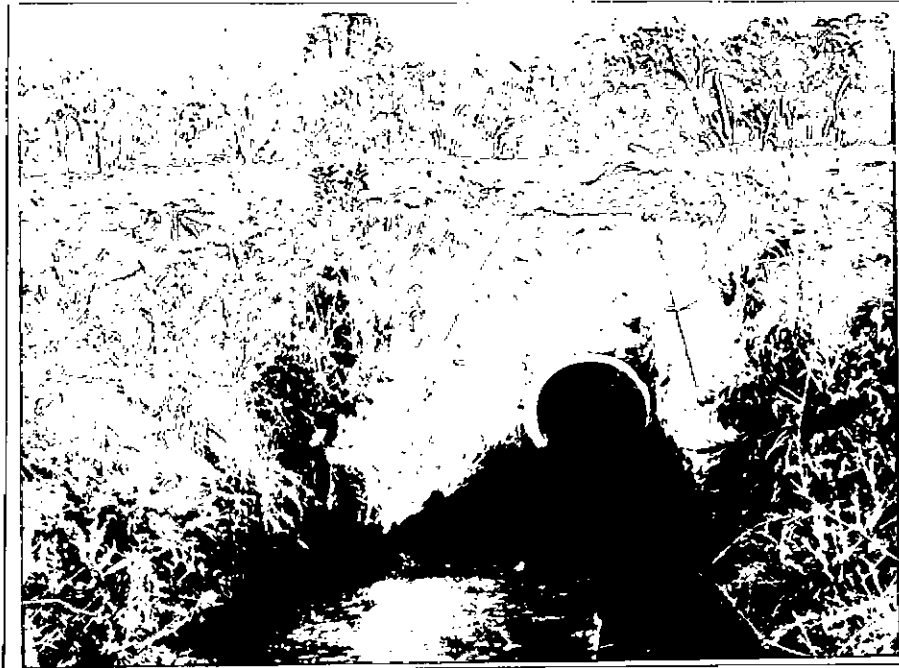
OBRA Nº 29 - VISTA DA LINHA DE TUBO DE CONCRETO Ø 0,80 m E ATERRO - CÔRREGO DO BACURI.
