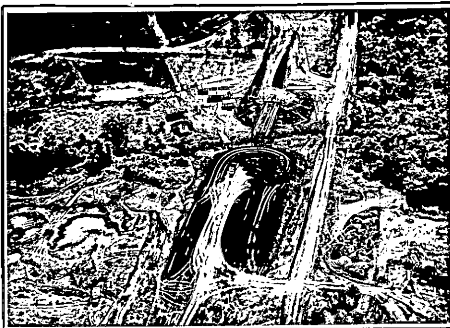
VISTA AÉREA DA PONTE DE CONCRETO, VÃO 52,00 m SOBRE O RIBEIRÃO RIO GRANDE - ESTRADA ILHA SOLTEIRA-APARECIDA DO TABUADO.
