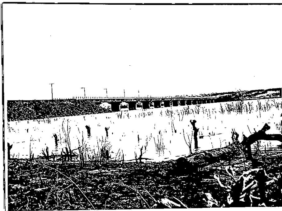
OBRA Nº 02 - PONTE SOBRE O RIO PÂNTANO, VÃO 525,00 m, COM ATERRO ENROCADO
