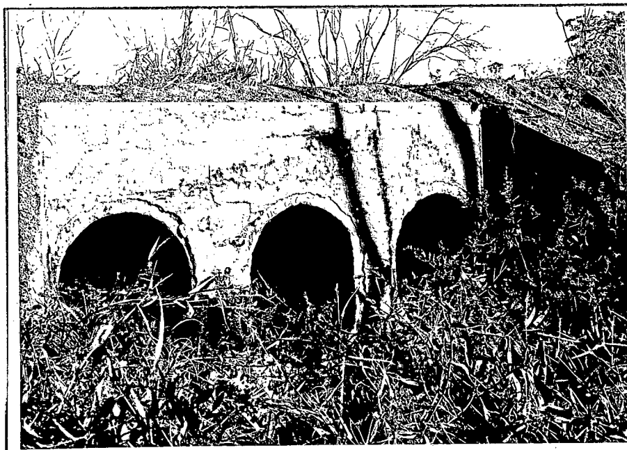
OBRA Nº 32 - VISTA DA LINHA TRIPLA DE TUBO DE CONCRETO - CÔRREGO DA VERTENTE.
