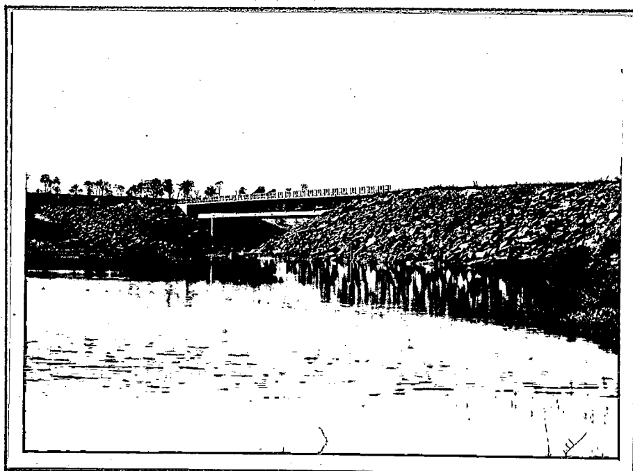
OBRA Nº 2 - PONTE SOBRE O RIO SÃO JOSÉ DOS DOURADOS. VÃO 52,50 m COM ATERRO ENROCADO.
