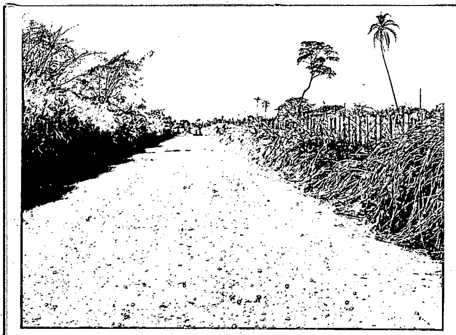
TRECHO A-B - VISTA GERAL DE UM TRECHO CONSTRUÍDO
