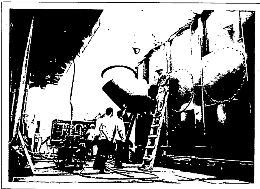
Montagem do suporte da bucha e interligação do cabo (H3)
