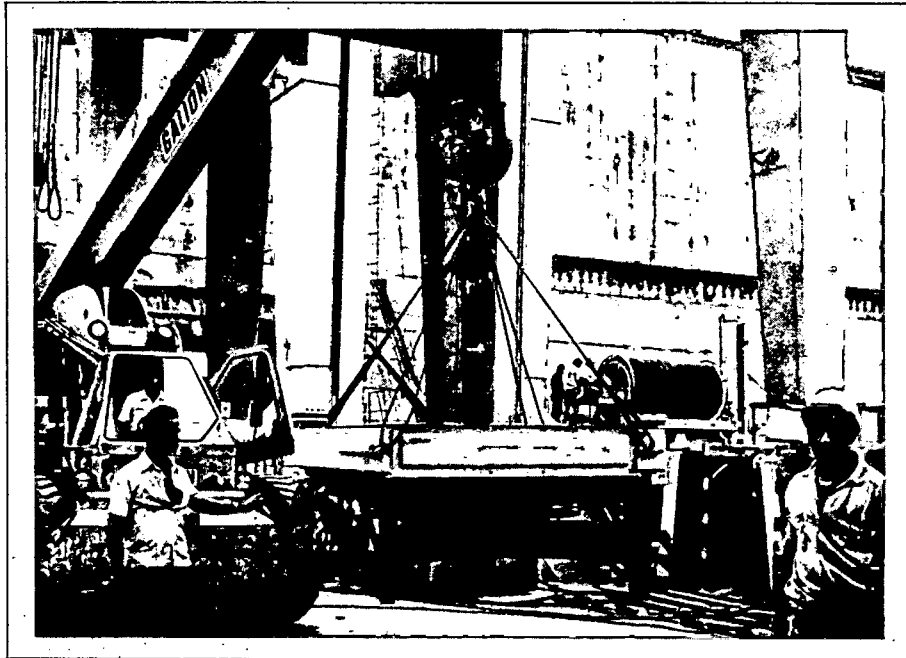
Posição de içamento para montagem do trocador de calor
