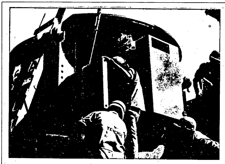
Fixação do suporte da viga lateral
