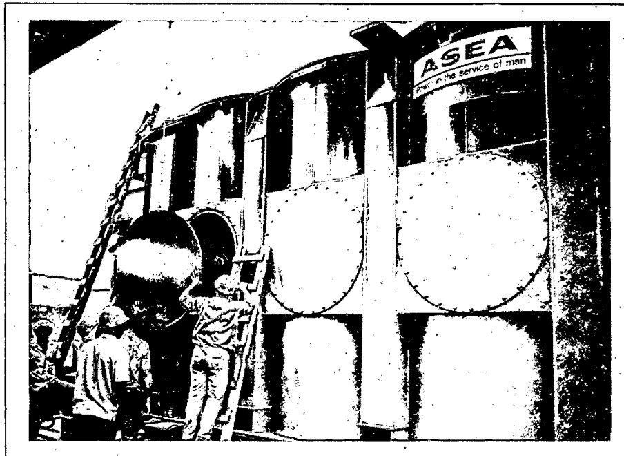
Remoção das tampas para montagem dos suportes das buchas.
