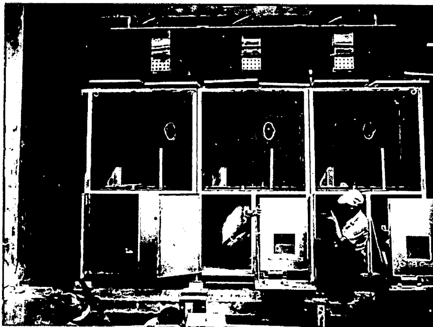
Preparação do cubículo para montagem dos acessórios.
