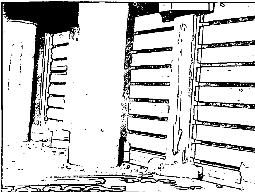
Garras dos tirantes posicionadas para solda.
