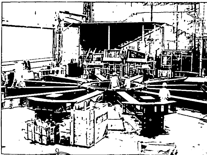
Montagem da cruzeta sobre a base de apoio de concreto.
