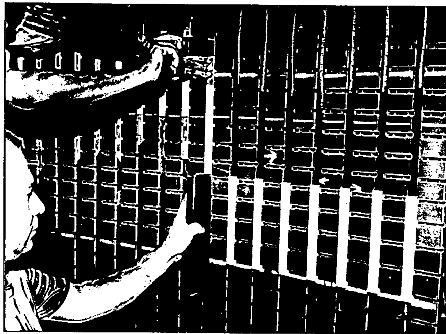
Colocação das cunhas provisoriamente.
