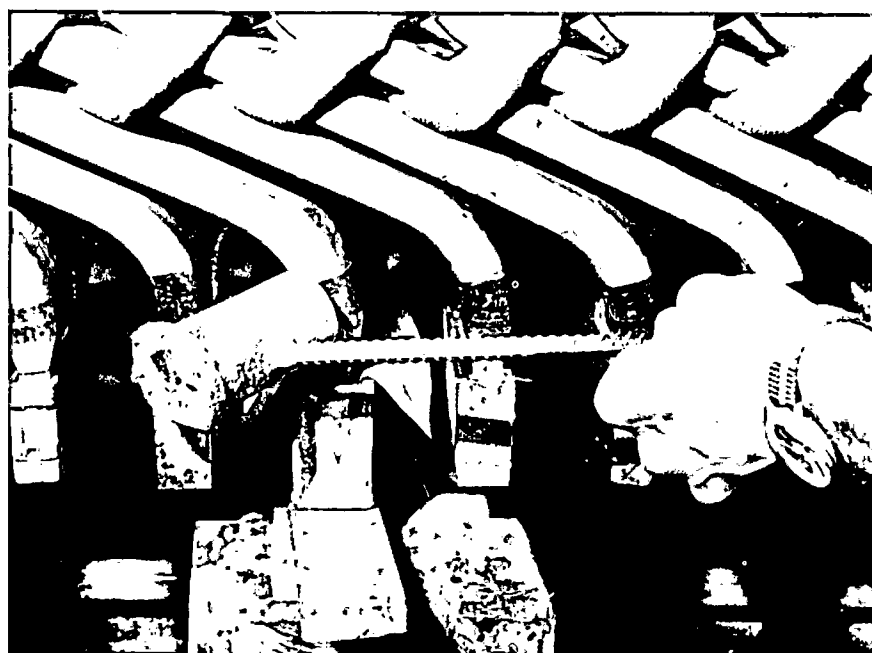
Complementação da solda utilizando-se cadinho.
