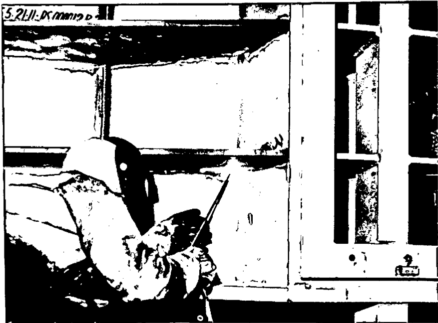
Soldagem das placas de reforço horizontal.
