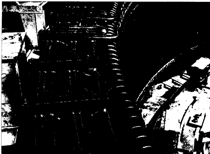
Vista parcial do barramento circular após concluída a montagem.
