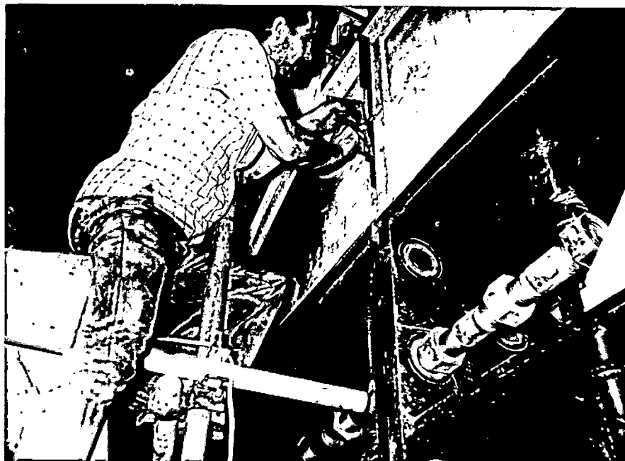
Colocação de calços metálicos para compen s ação da folga entre os segmentos .
