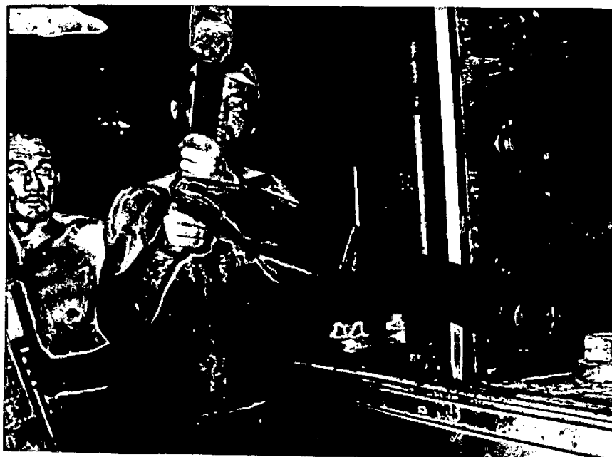
Aperto preliminar dos parafusos de acoplamento entre os segmentos do Estator.
