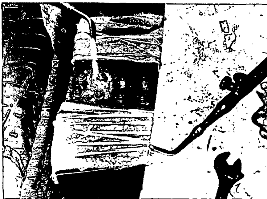
Aquecimento do terminal para o estanhamento.
