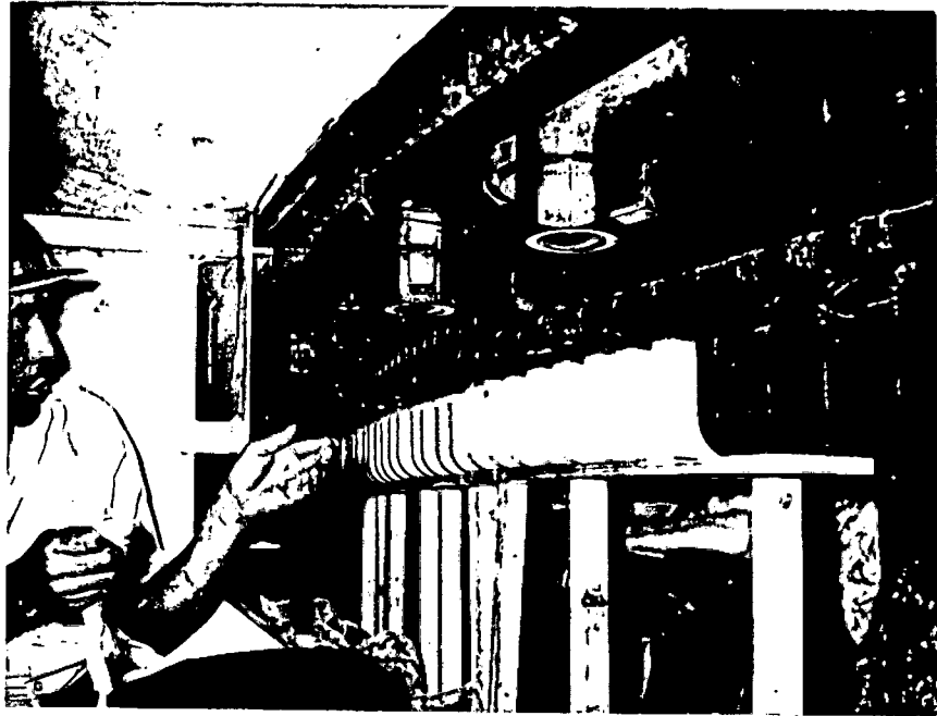
Capas de fibra-de-vidro para proteção dos terminais.
