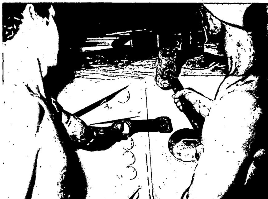
Acoplamento dos braços ao cubo.
