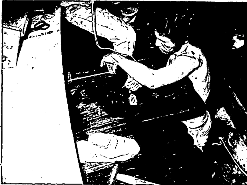
Isolação dos terminais. Etapa final.
