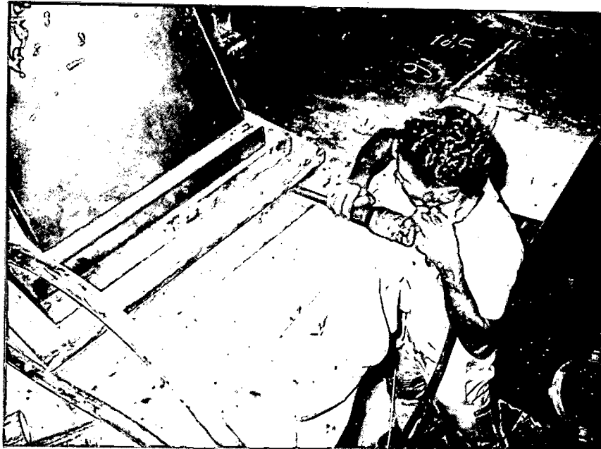
Martelamento da solda de fixação da base do estator.
