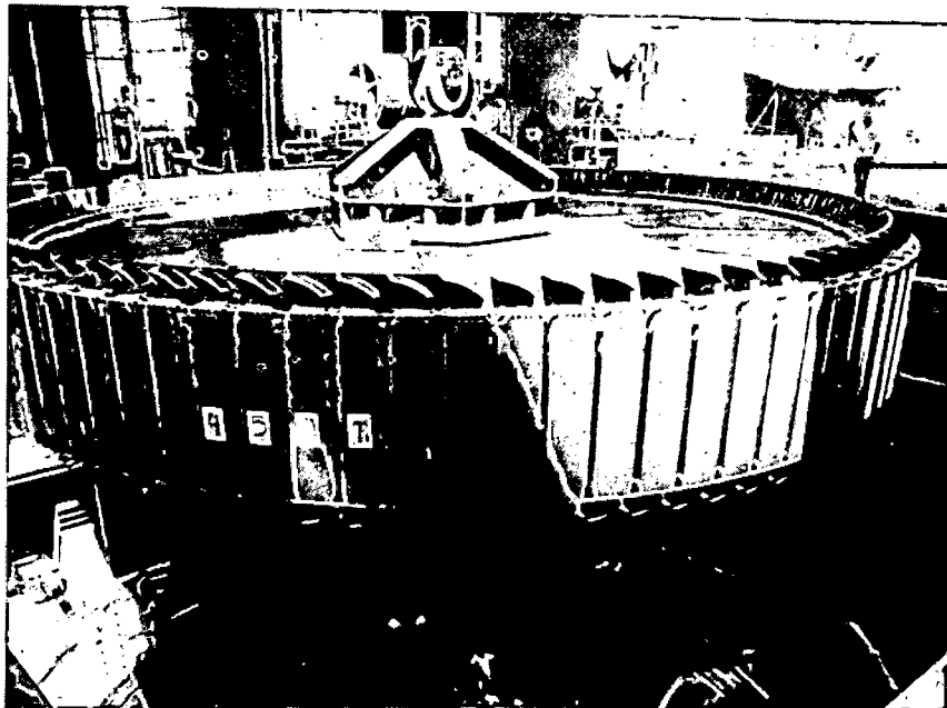
Descida do rotor ao poço do gerador
