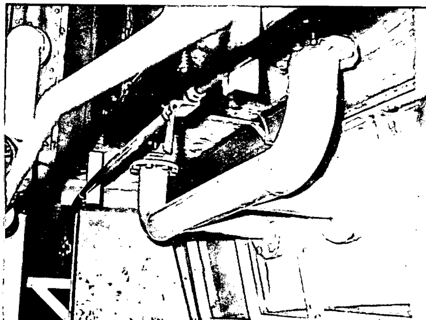
Tubulação ligando a câmara de arrefecimento à car ca ça do estator.
