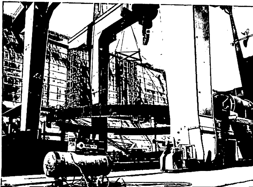
Câmara superior sendo transportada para o HM, para acoplamento com a tampa do poço do gerador.
