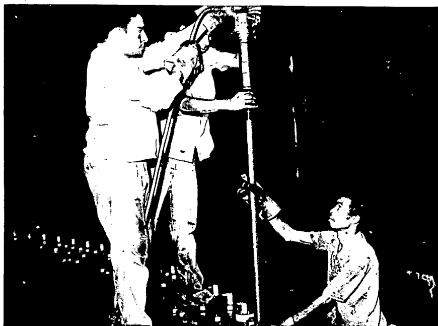
Sequência de operação, com o auxílio de martelete pneumático.
