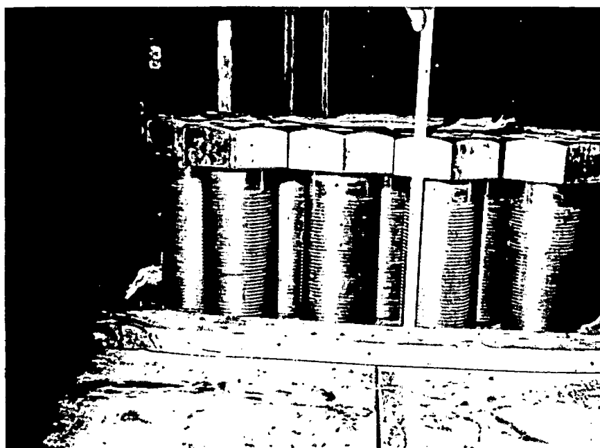
Detalhe dos parafusos, cabeças sextavada M80X4X190mm. Total de duzentas e dezesseis unidades.
