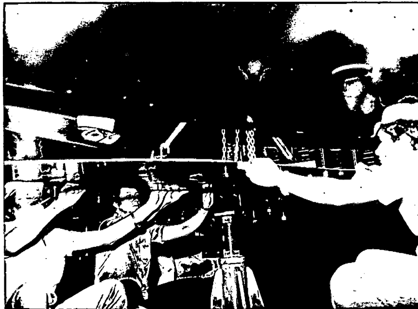
Montagem das chapas diafragmas inferiores utilizando-se talha de corrente manual.
