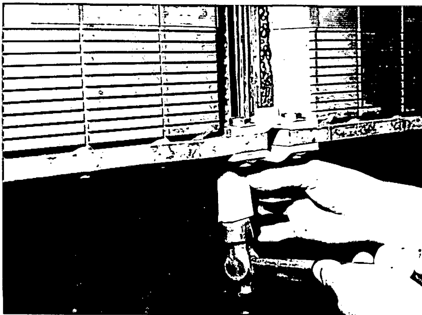
Colocação de calços de madeira para aperto dos parafusos de fixação dos flexíveis.
