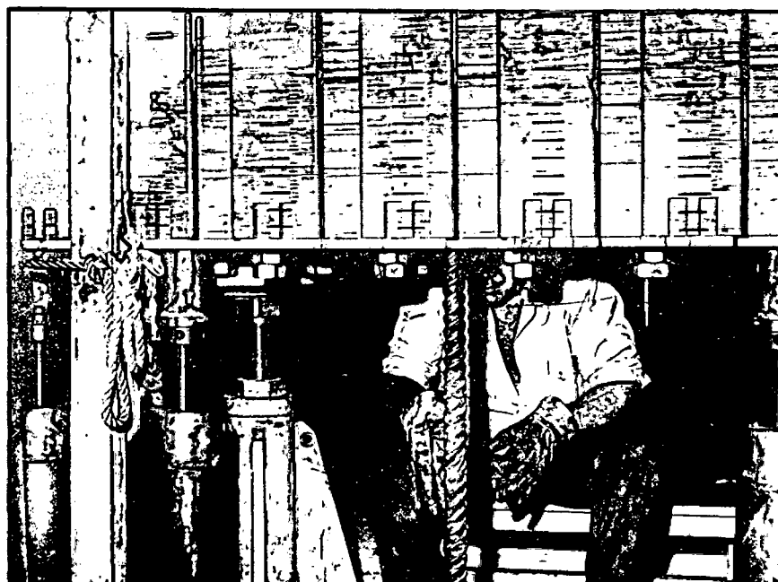
Posicionamento da brocha na parte inferior do furo do tirante.
