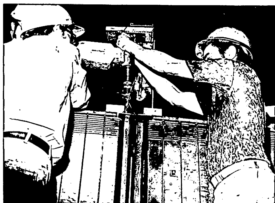
Furação das barras da gaiola de amortecimento, parte inferior, com furadeira elétrica.
