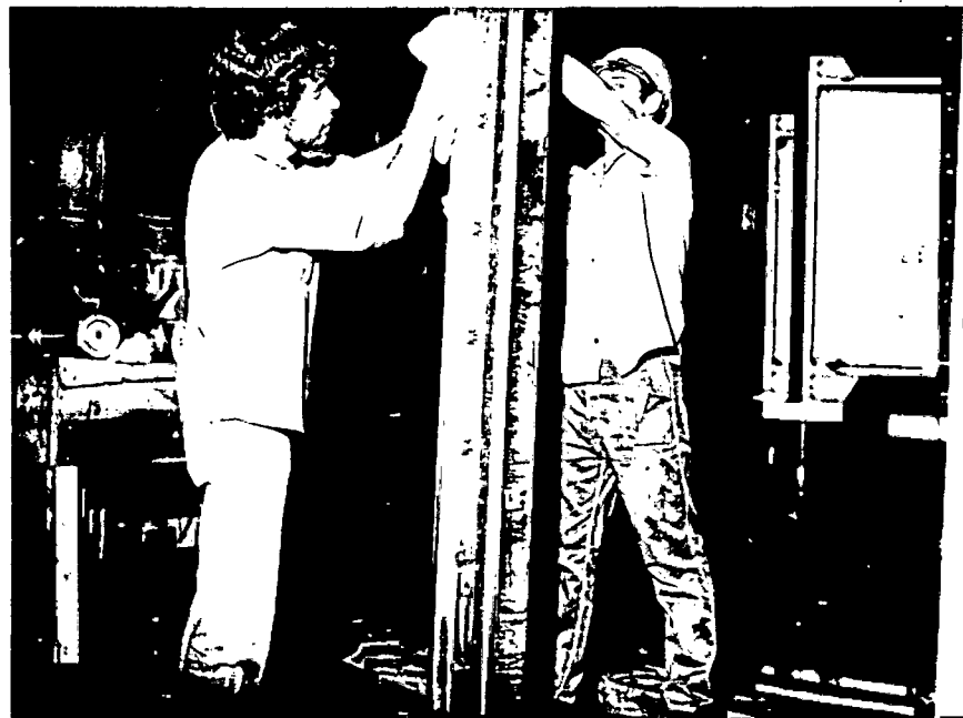
Limpeza das junções elásticas no sentido vertical usando Chlorethene-nu e lixa, utilizando-se uma das Pontes Rolantes de 20t.
