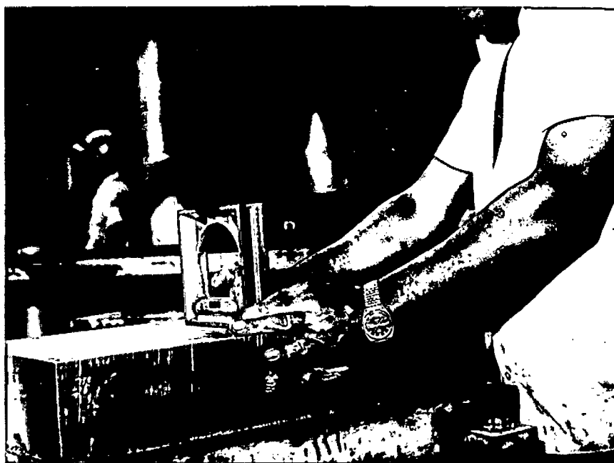
Nivelamento das placas de apoio utilizando-se "nível de engenheiro".
