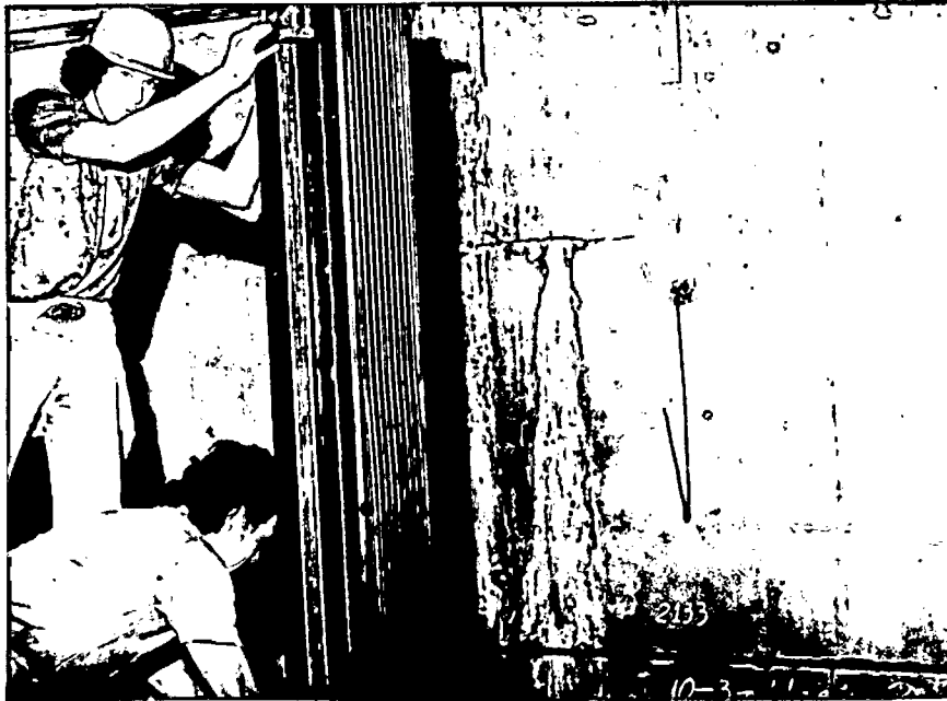
Início da introdução do pólo na ranhura do anel magnético.
