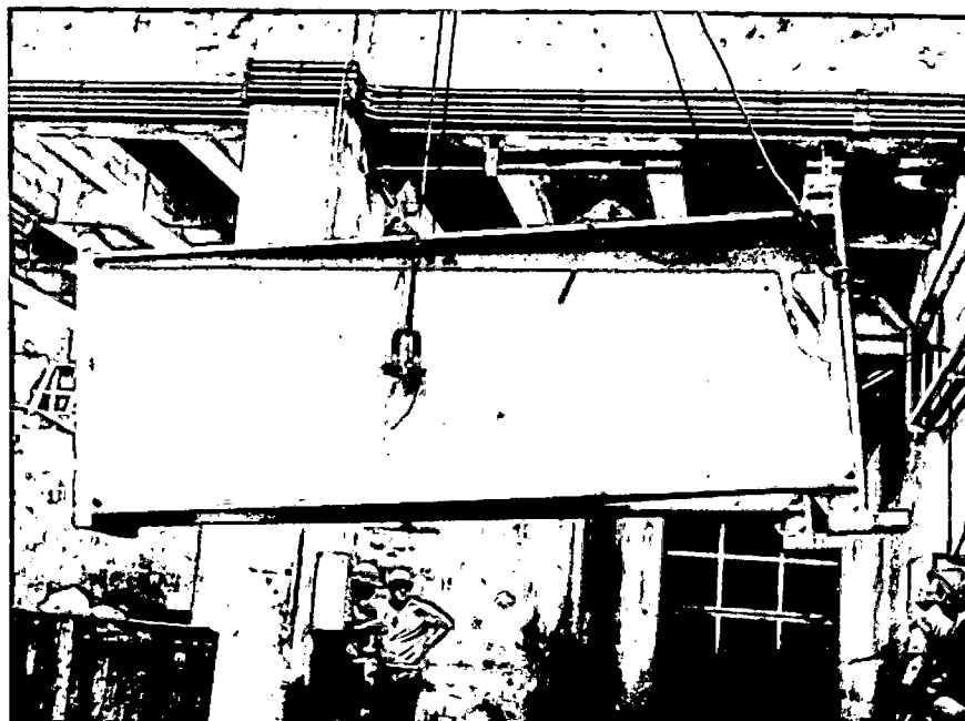
Descida dos braços da aranha da cota 292,00 para o Hall de Montagem com auxílio do Pórtico de 280t.
