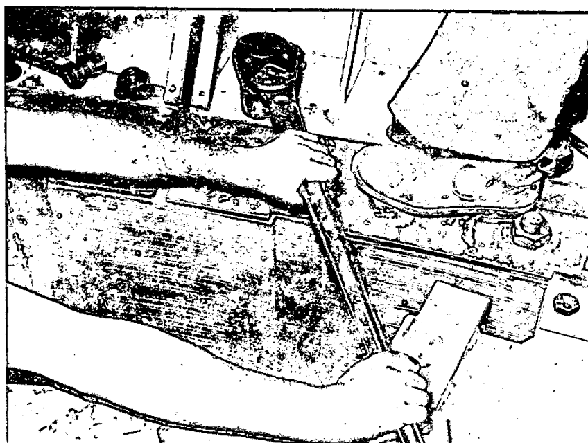
Fixação final utilizando um torquímetro
