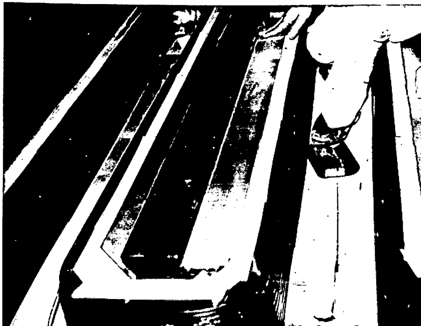
Limpeza das faces de acoplamento dos polos , usando-se lixa.
