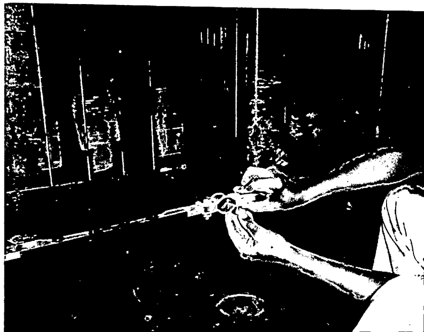
Montagem das conexões das barras da gaiola - amortecedora.
