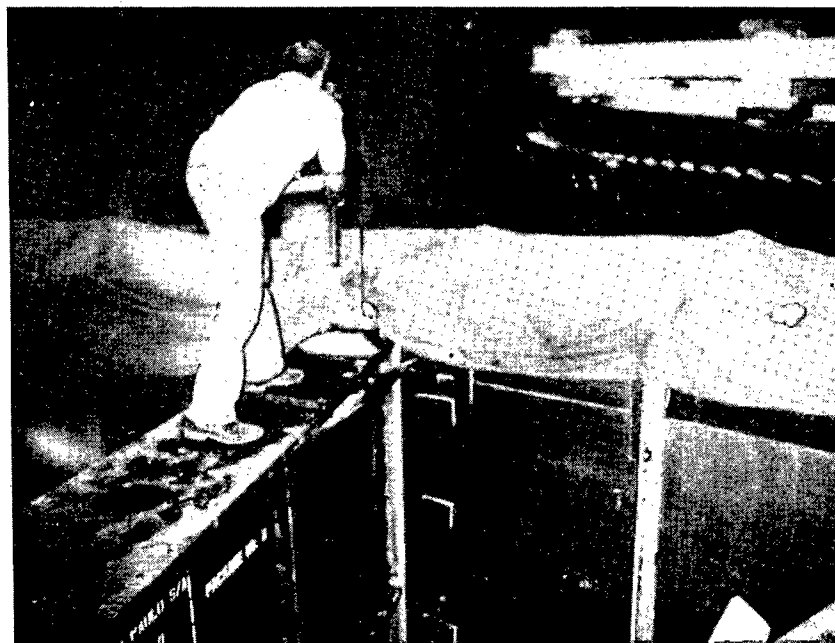
Introdução das chavetas usando marreta, notando-se o gelo colocado.
