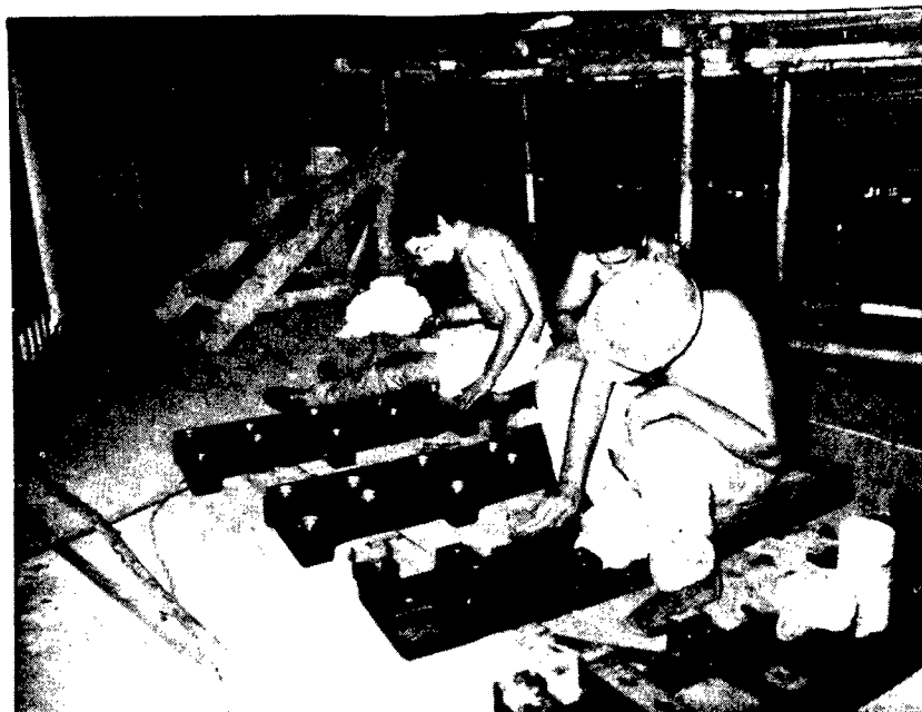
Limpeza e preparação dos elementos da pista de freio.
