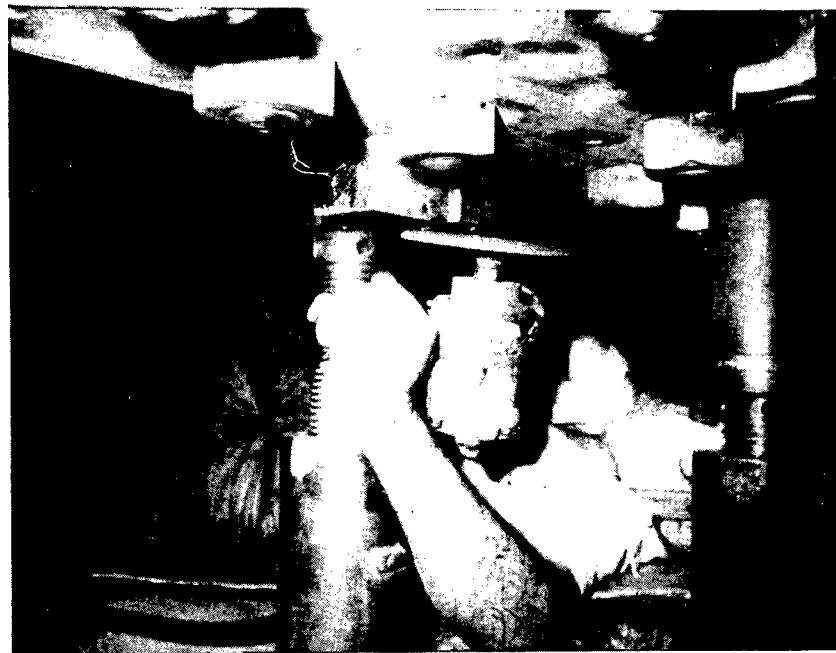
Corte das extremidades inferiores das chavetas
