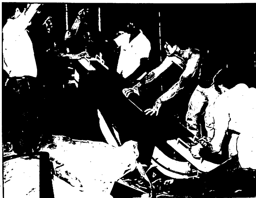
Levantamento do polo, utilizando-se ponte rolante de 20 t .
