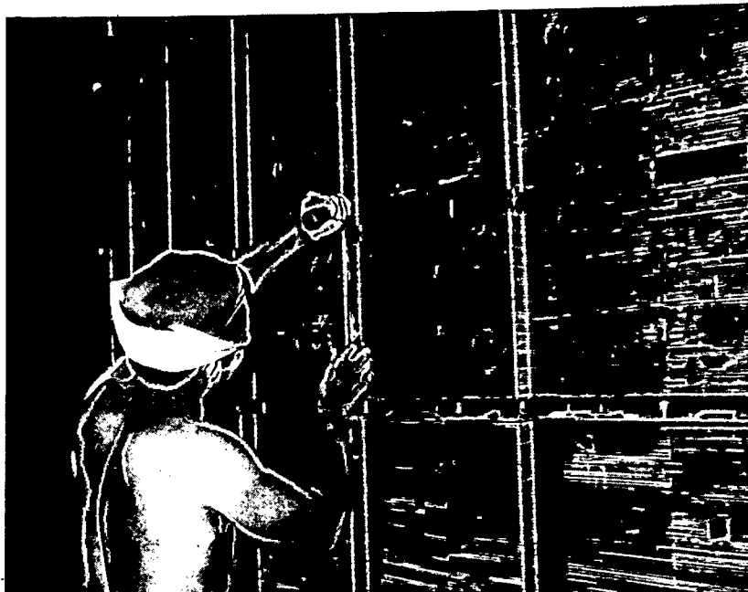
Ajuste e limpeza das ranhuras tipo rabo de an dorinha.
