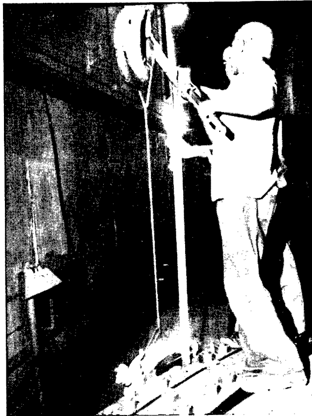
Introdução parcial das chavetas cu neiformes dos polos.
