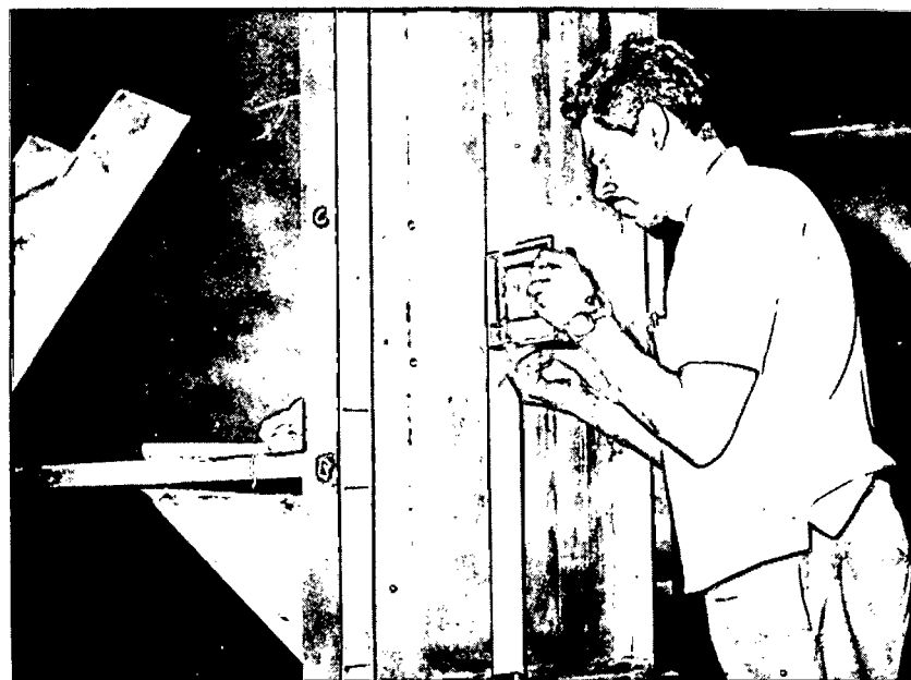
Verificação da verticalidade do braço da aranha (máx. 0,03 mm).
