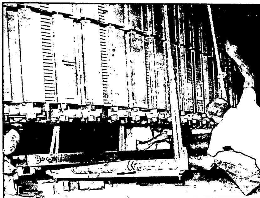
Montagem da pista de freio com auxílio da ponte de 20 t.
