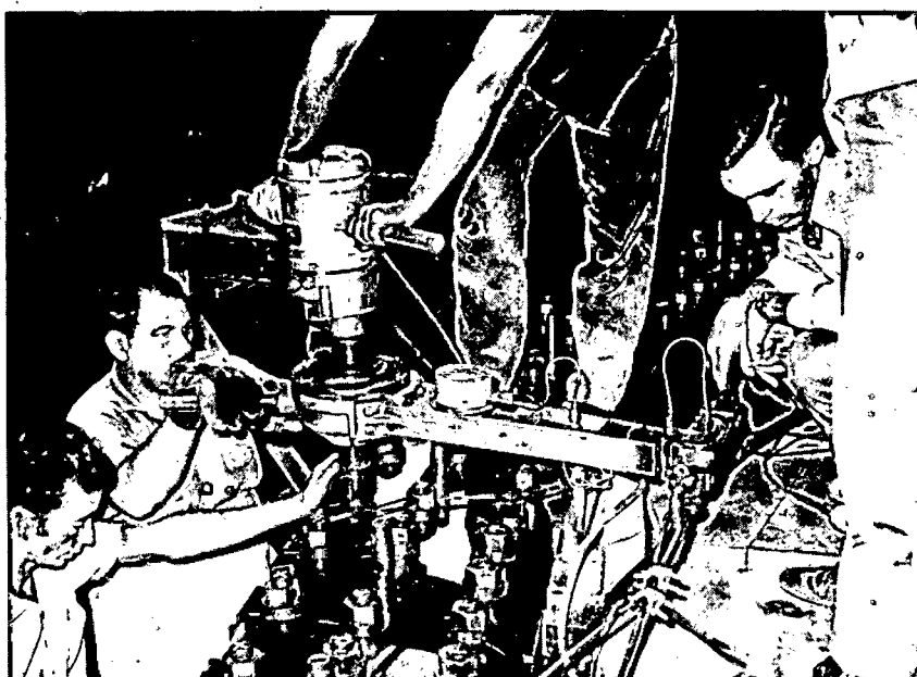
Aperto dos parafusos com torquímetro e máquina elétrica de 440 V.
