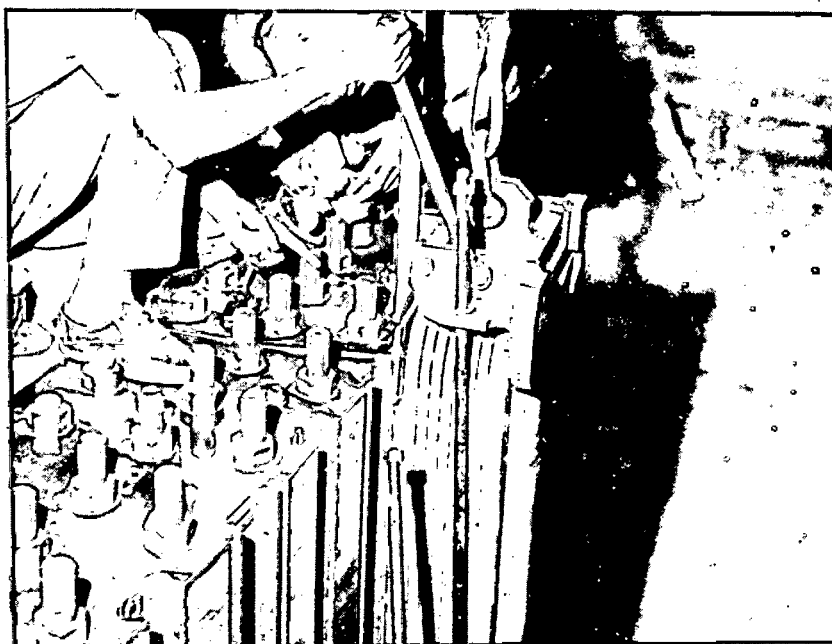
Desmontagem do dispositivo de levantamento.
