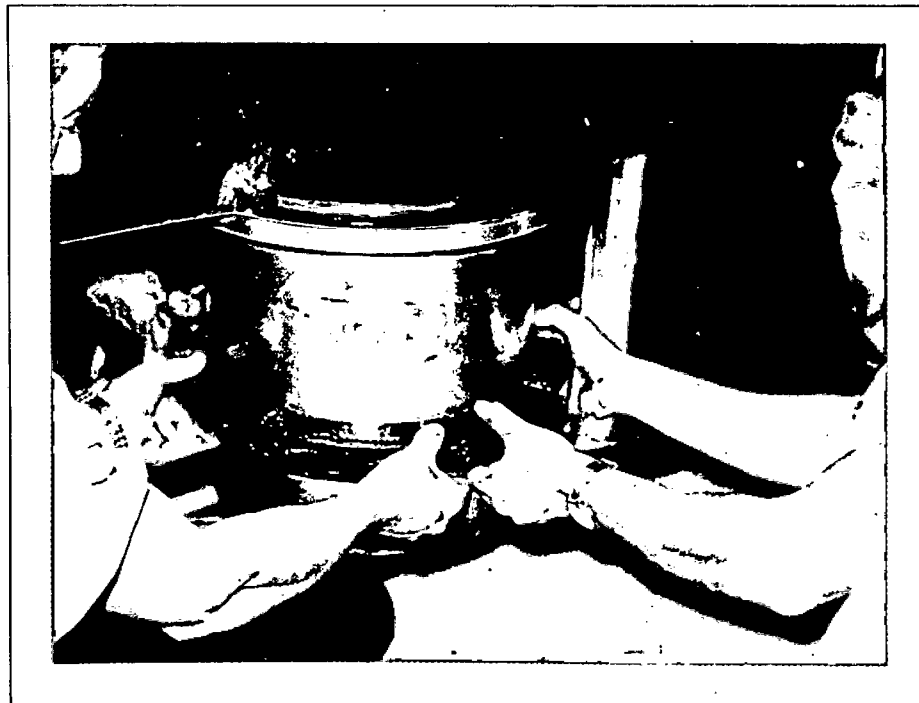
Colocação da vedação de borracha e couro em torno do munhão.
