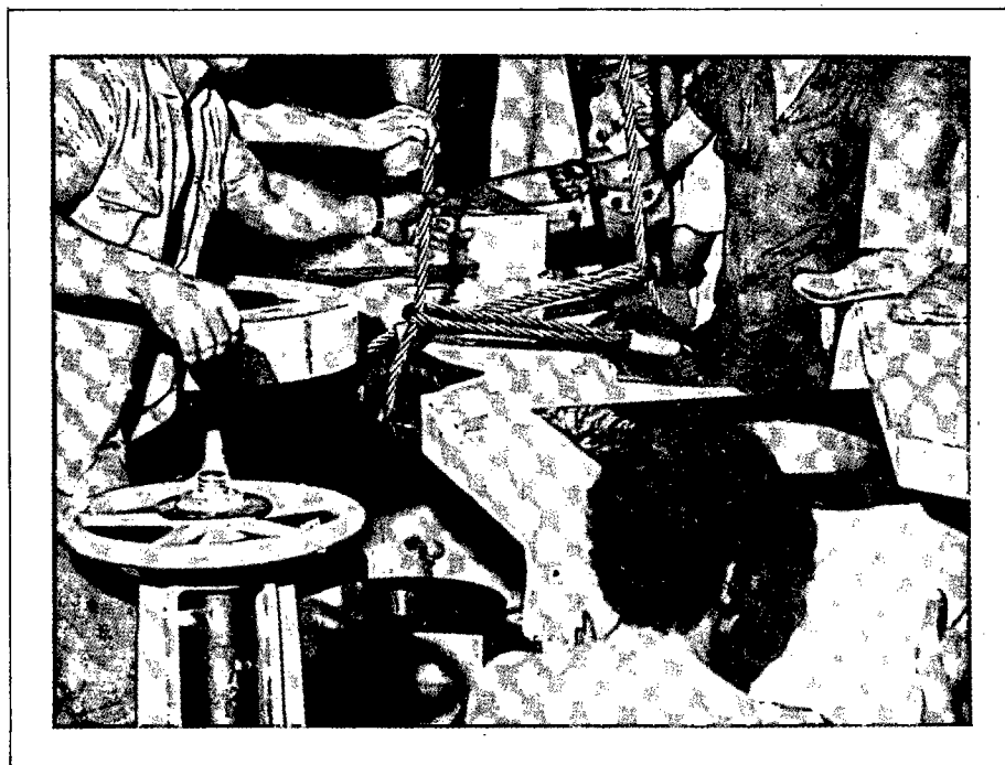
Montagem da biela de ligação do servomotor com o anel de regulação
