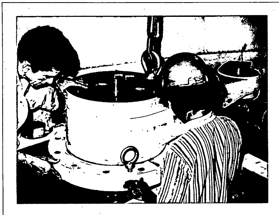
Montagem de um mancal de escora de palheta móvel.
