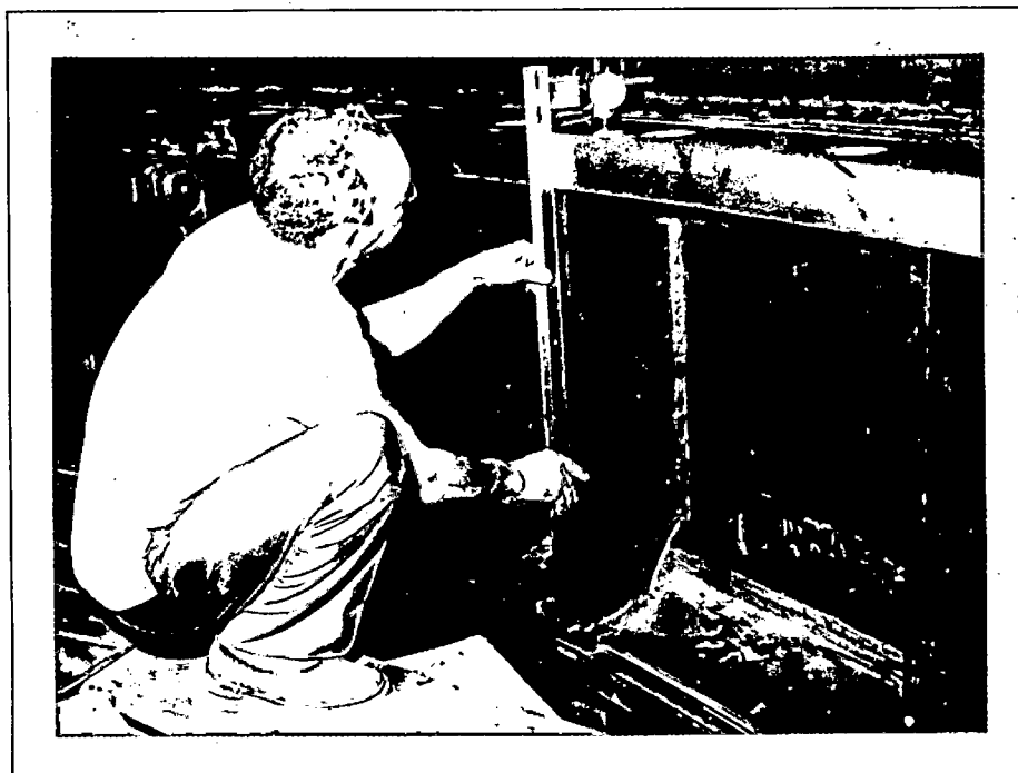
Verificação de medida entre a canaleta e o apoio inferior da tampa no pré-distribuidor.
