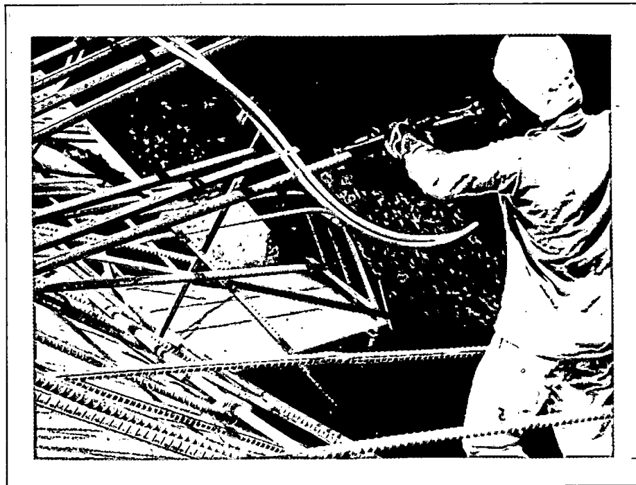
Chumbadores de \varnothing 1" do pit liner
