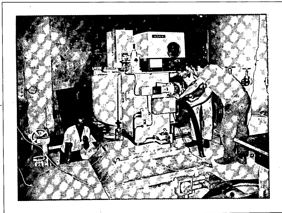
Montagem do regulador eletrônico ASEA.
