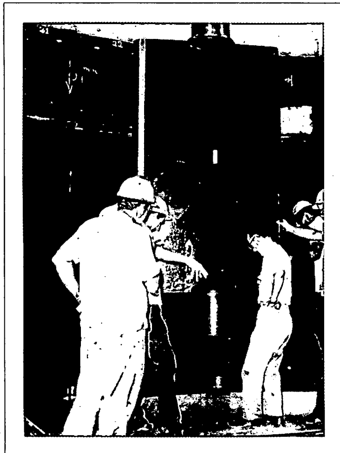
Montagem de palheta móvel.
