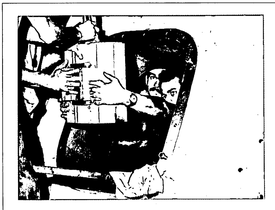
Introdução dos patins pela porta de inspeção da estrutura de suporte do mancal de escora (vide operação nº 15)
