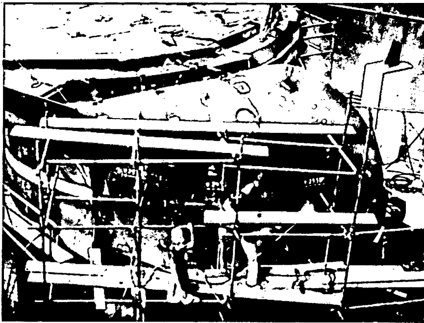
Montagem da virola 23, auxiliada pela Ponte Rolante de 35t. Peso : 2.600 kg.
