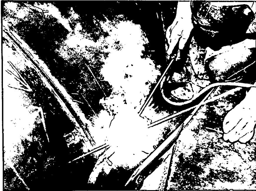
Solda da virola da Caixa espiral com o Pré-distribuidor ( radial ).
