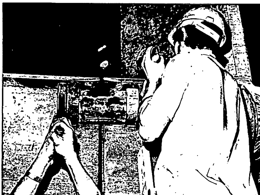
Emendas dos quartos, travamento com parafu sos M64 X 380mm.
