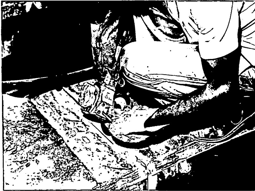
Preparação do chanfro com lixadeira pneumática.
