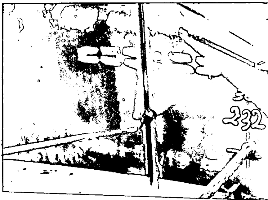
Aquecimento da chapa com gás propano a 150°C, para soldagem.
