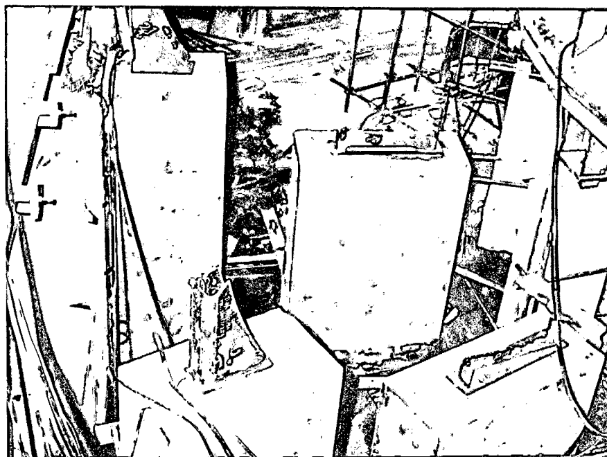
Disposição dos apoios da Caixa espiral sobre as sapatas de concreto.
