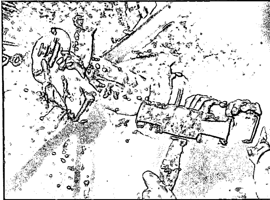
Travamento nas emendas com parafuso M64X380
