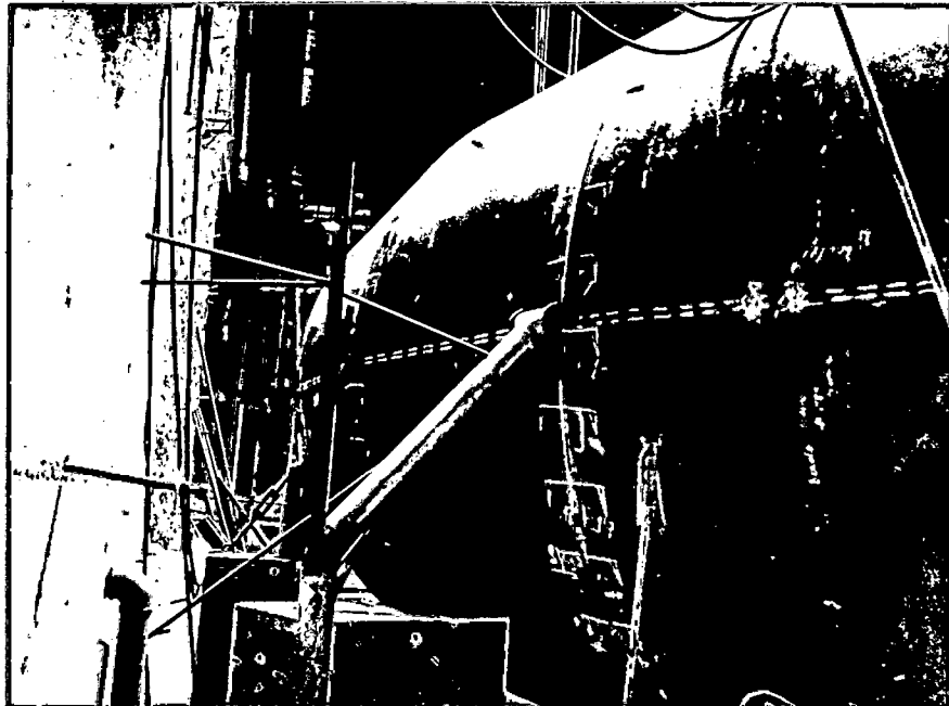
Tubo para drenagem exterior da Caixa Espiral Schedule 40 - \varnothing 6".
