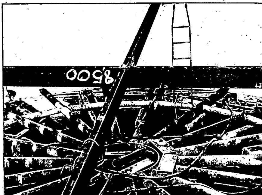
Contraventamento do anel 5 com viga "U" de 10"
