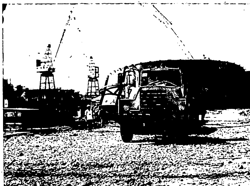
Transporte de um anel da COEMSA. Ao fundo - dois guindastes Stothert & Pitt.
