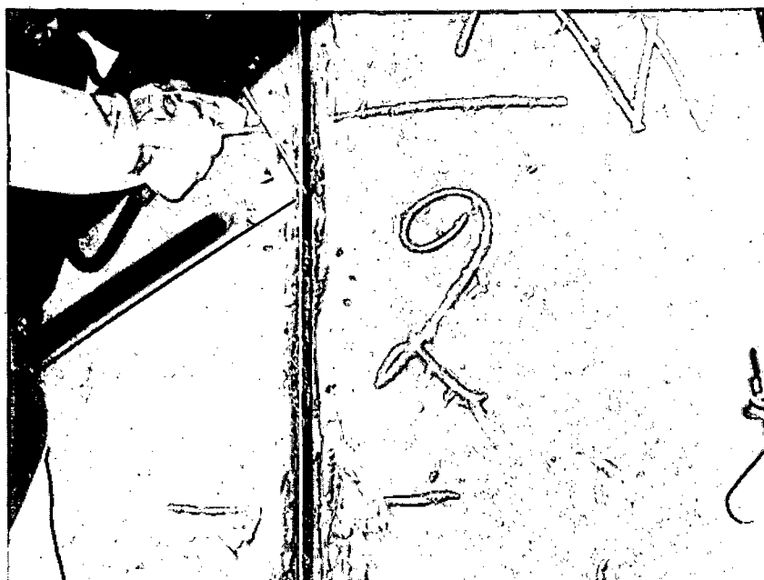
Divisão da solda vertical em trechos de acordo com o esquema proposto.
