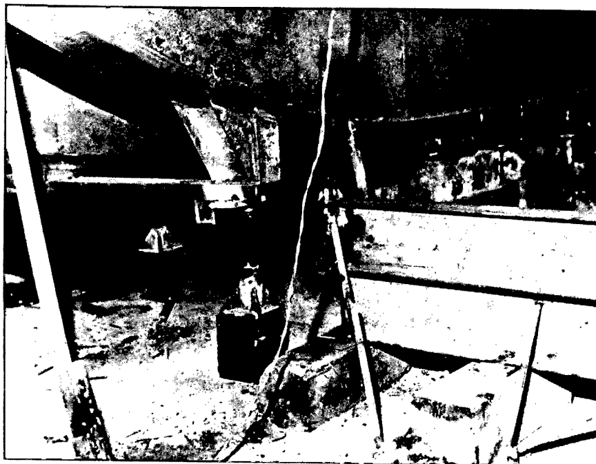
Macacos tubulares de apoio definitivo do anel 2.
