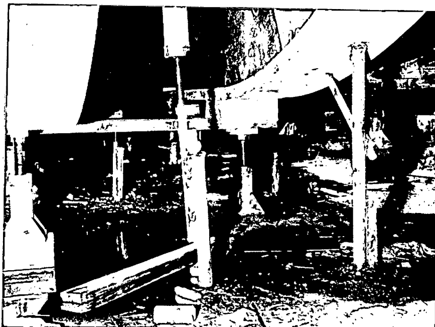
Vista geral do sistema de apoio da Blindagem com macacos tubulares. Quantidade: 23 unidades
