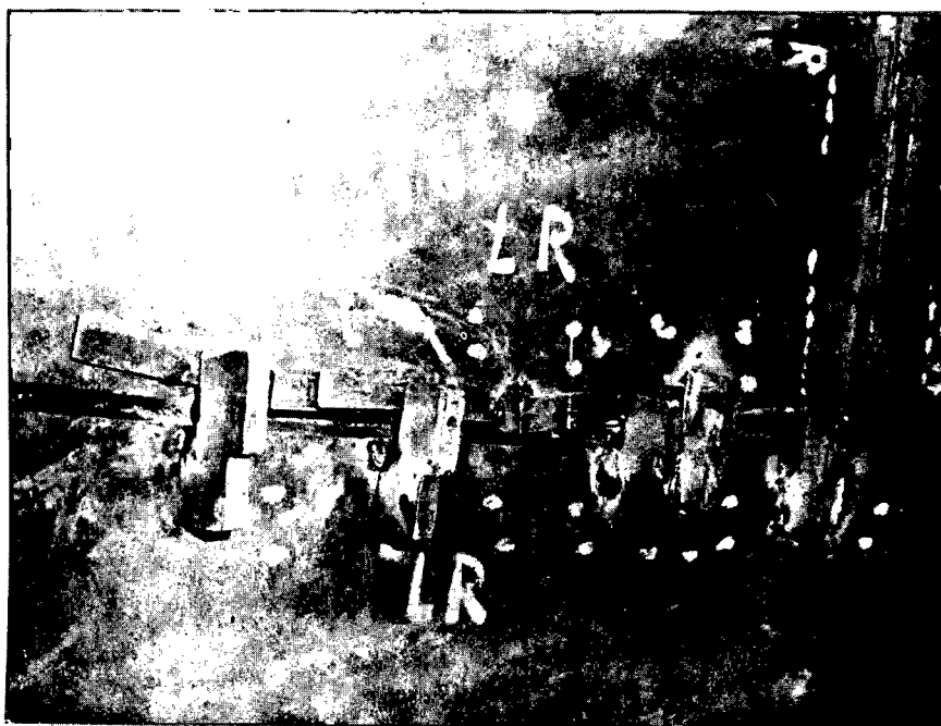
Travamento e ajuste interno do anel 1 com o anel 2.
