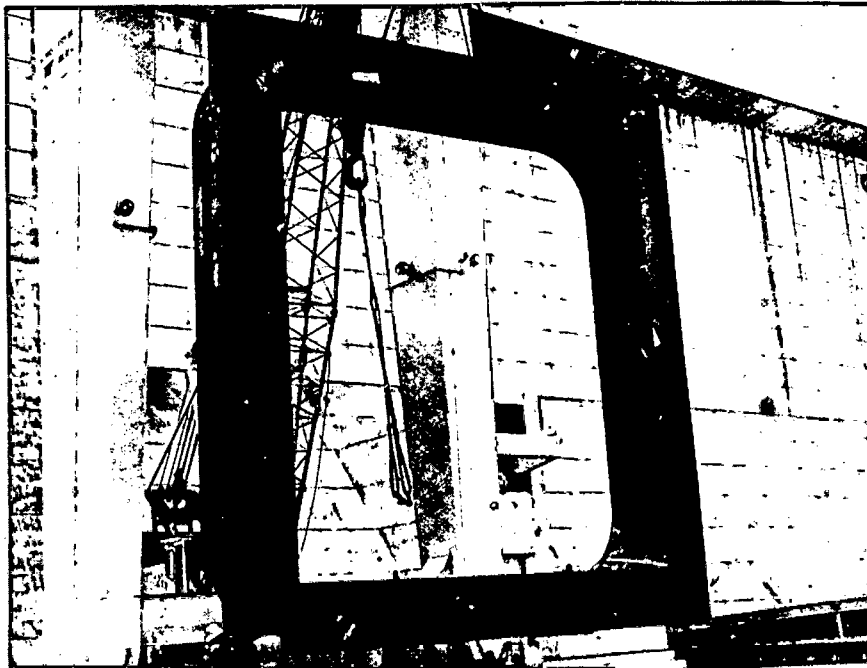
Término da operação. Anel 1 na posição correta e retirada do estropo da soleira.
