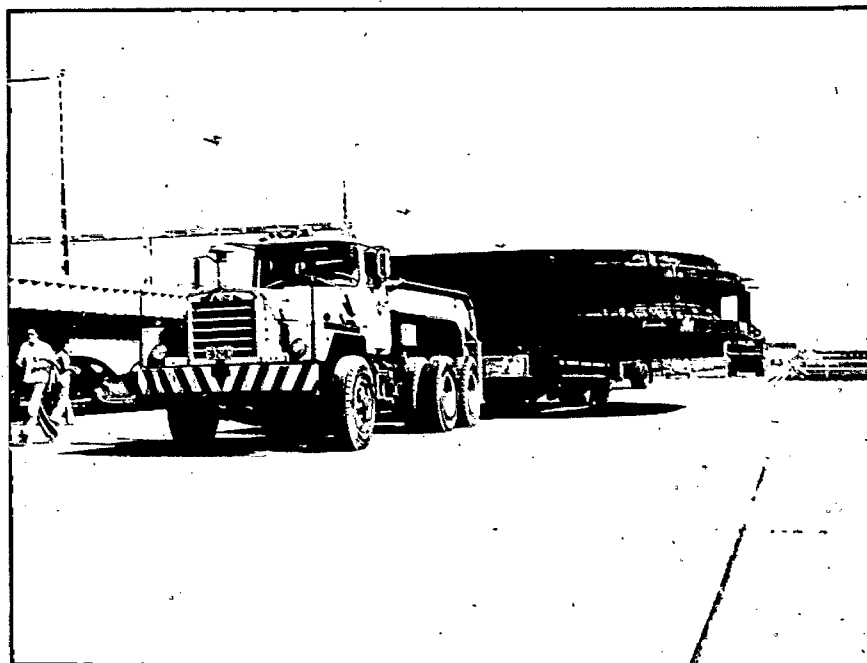
Transporte do anel 2 para a cota 292 - Barragem de Gravidade.
