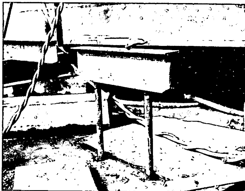
Suporte usado para teste de arrancamento
