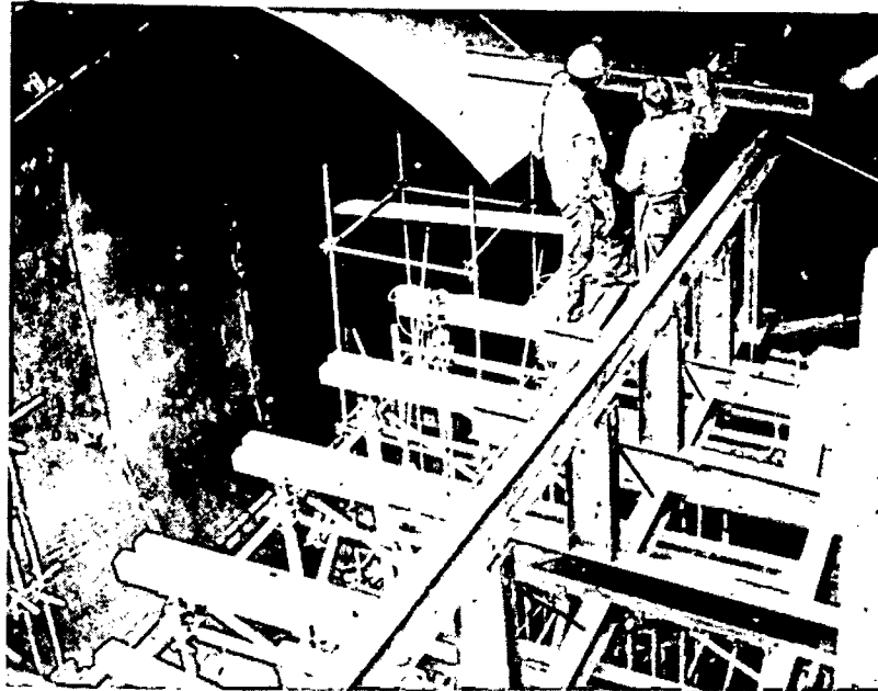
Vista parcial do cimbramento e da viga de deslizamento
