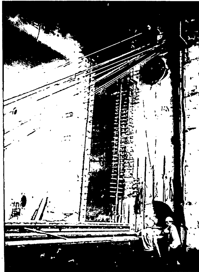
Roldanas e cabos preparados para o levantamento da lateral esquerda
