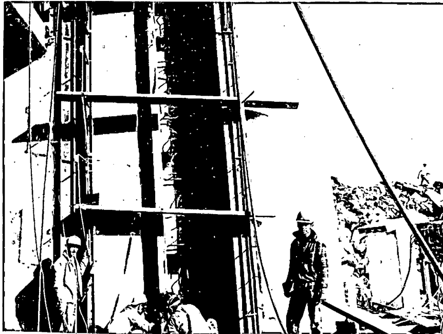
Guia lateral do limpa-grades primeiro tre cho em posicionamento.
