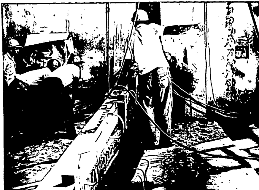
Soleira colocada no nicho com auxílio de guincho Galion.
