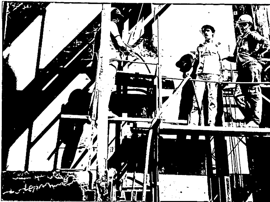
Preparação do nicho da guia lateral do limpa-grades.
