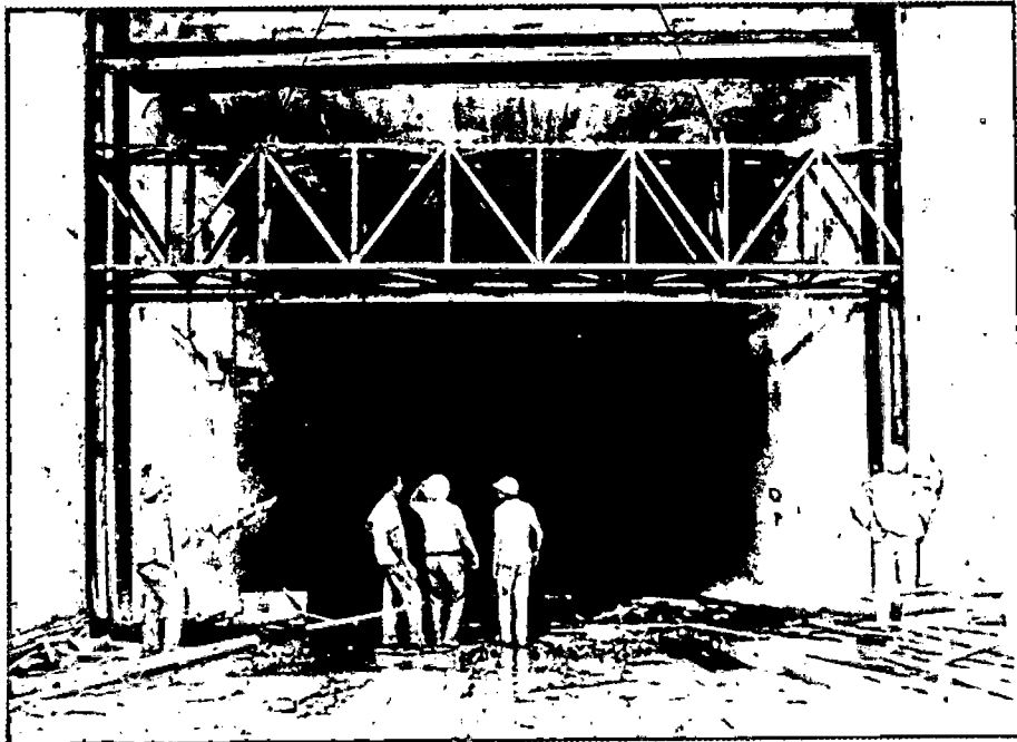
Passagem de gabarito no quadro de vedação .
