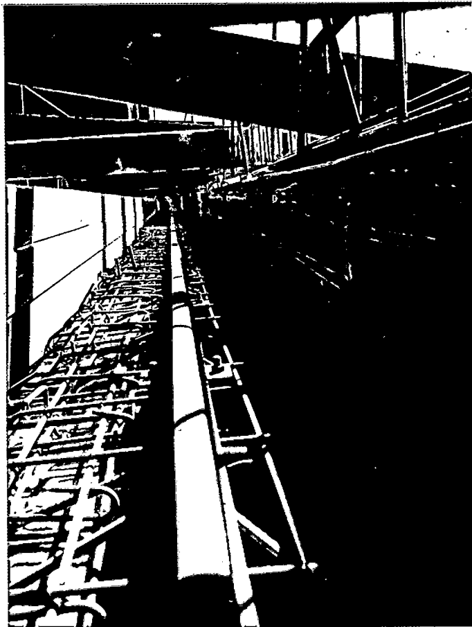
Vista parcial da ferragem do concreto secundário.
