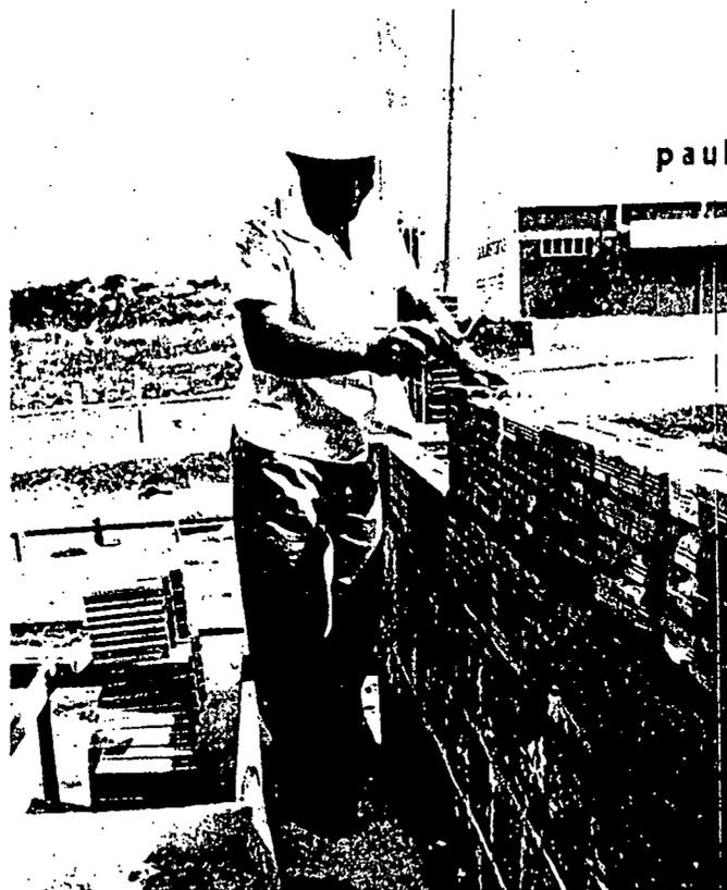
Alvenaria sendo executada, com argamassa de areia fina e "resíduo de carbureto".
