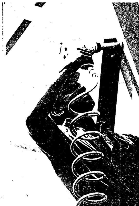
Reaperto de uma junção de montantes. Nesta posição, a disposição dos parafusos dificulta a operação de reaperto tradicional, ao contrário da operação com ferramenta pneumática.
