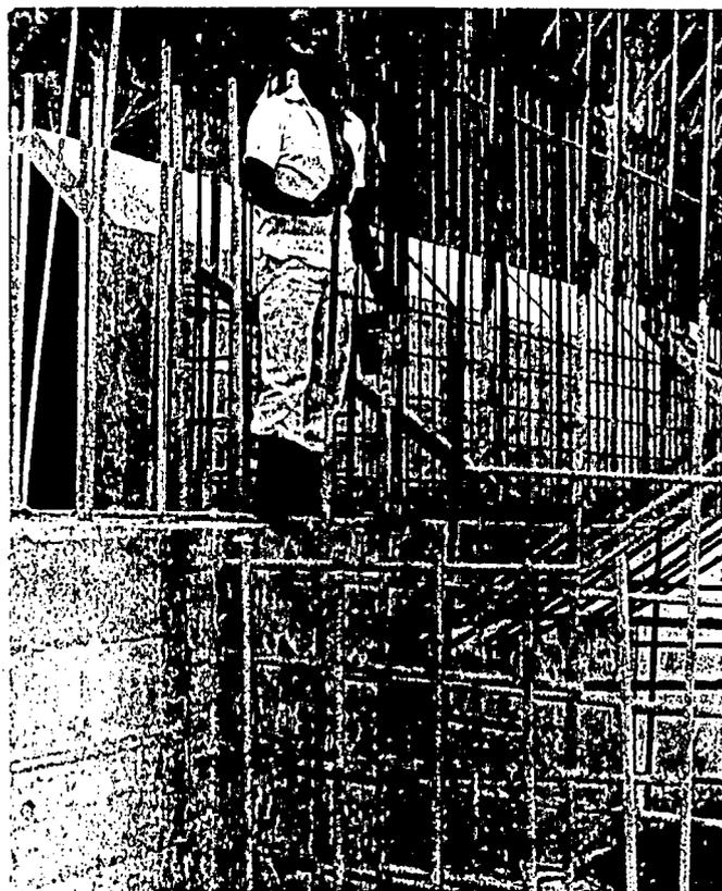
Pintura provisória das barras com calda de cimento mais Silicato de Sódio Neutro, em uma única demão aplicada com trincha.
