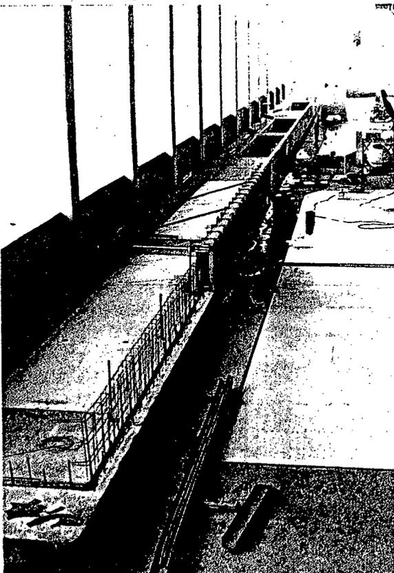
Vista geral. Ao fundo, nota-se o trecho de muro já executado. Em direção ao 1<sup>o</sup> plano da foto, vê-se um lance de fôrmas montado e a ferragem do trecho seguinte a ser concretado. Pode-se observar também a relativa ordem e limpeza do local, apesar de estar em obras.
